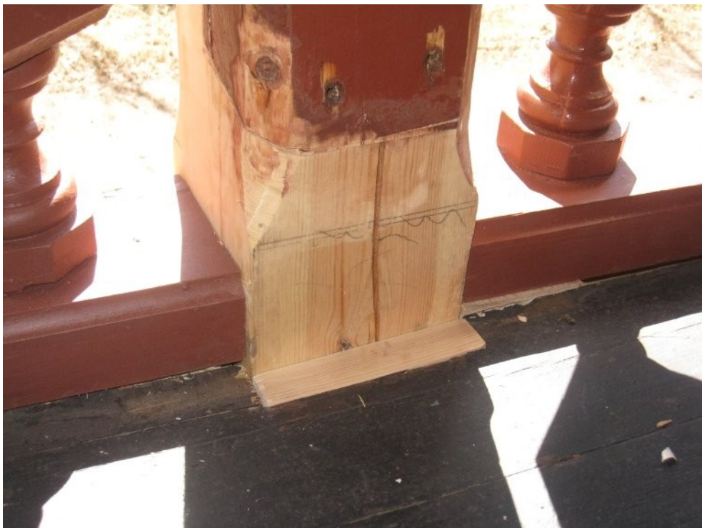
Kolmen pylvään kohdalle jäänyt rako paikattiin puukiilalla.
