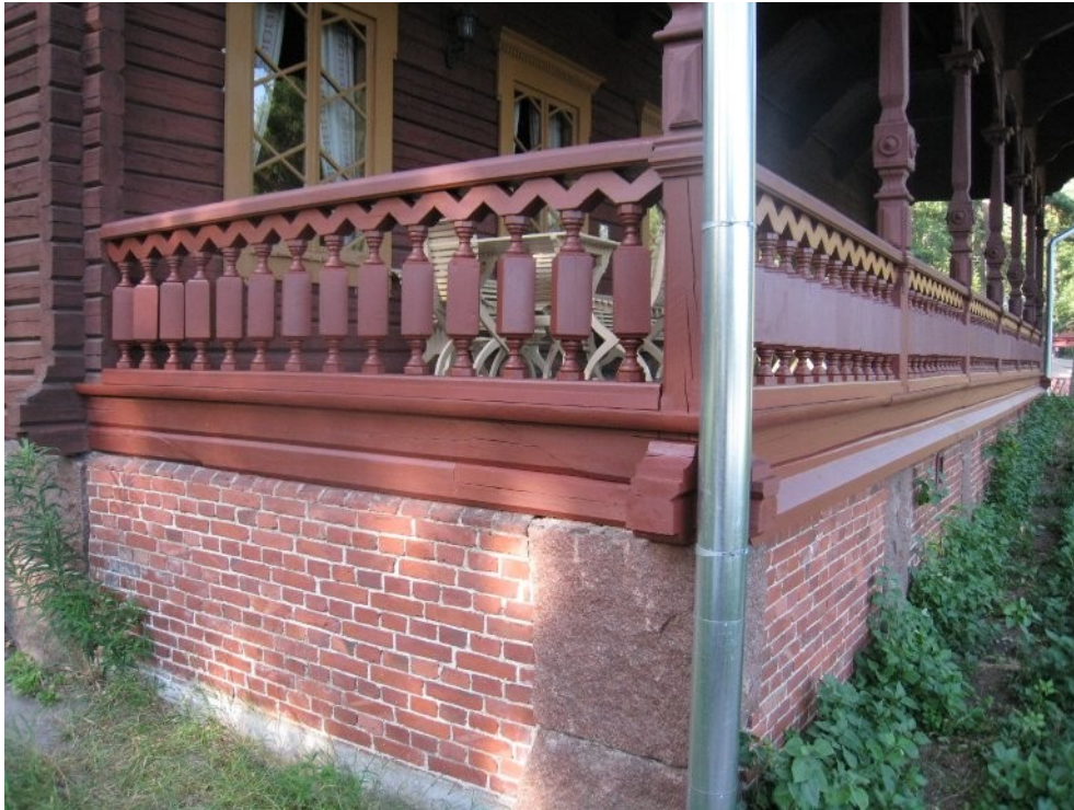
Valmiiksimaalatut kaiteet. Alakuvassa näkyy myös kaiteiden alapintaan asennettu pieni peitelista.
