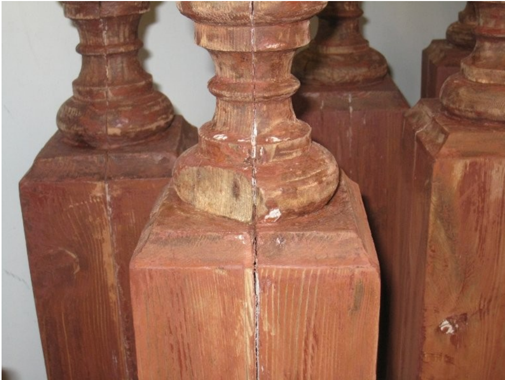
Maalinpoiston jälkeen. Sorvatuista osista paikattiin vielä muutamia kohtia, joista puuttui palasia.
