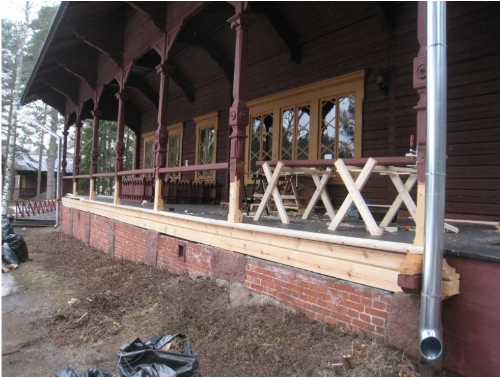
Reunalankkujen asennustyö (ylempi kuva) ja käsijohteiden paikkaus (alempi kuva)
