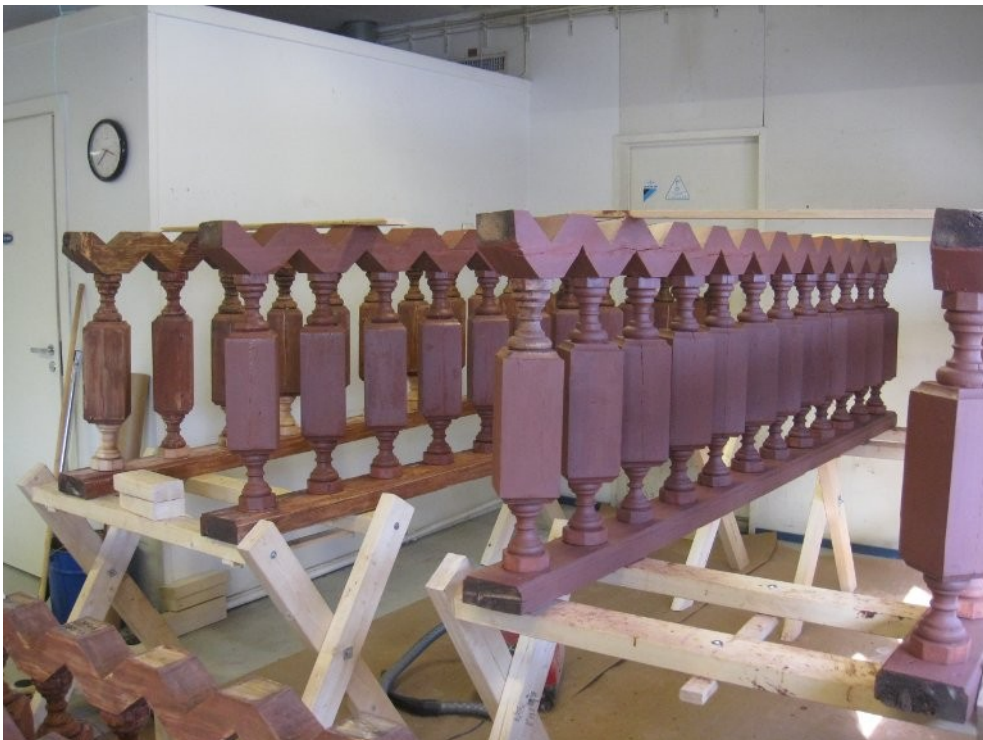
Kaiteet pohjamaalattiin verstaalla kahteen kertaan Tikkurilan Linpellavaöljymaalilla.
