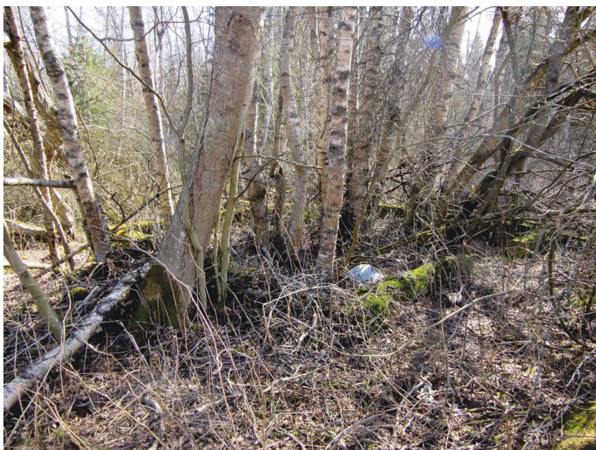
Rakennuksen betonikehikko kuvattu lounaaseen.
