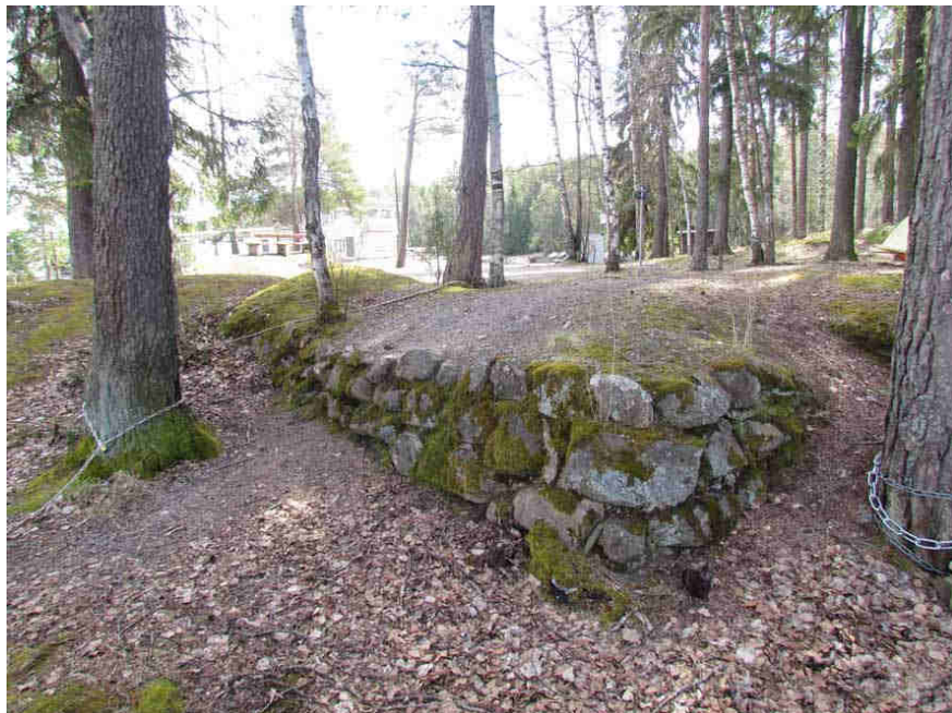
Kuva 21. Kivetty pengerr kuvattuna luoteesta. (Kuva: Tampere Rauhaniemi 2016:14)
