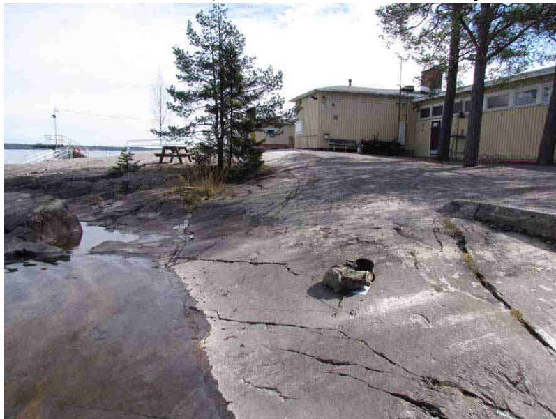
Kuva 9. Uuden hakkauksen sijaintipaikka kuvassa olevan repun kohdalla. kuvattu länsilounaasta. (Kuva: Tampere Rauhaniemi 2016:3)
