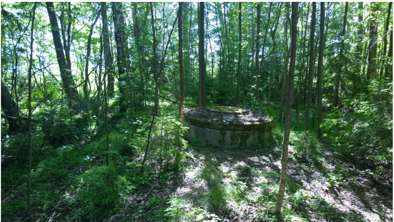
AKDG 4722:31. Virolahti Kelkkaniemi. Kaivo, luoteesta. Kuvaaja: Petro Pesonen.
