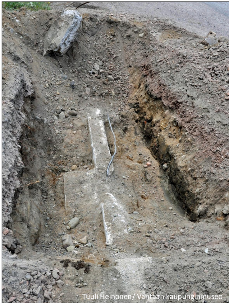
Kuva 8: Koeojan 2 betonirakenteet. Kuva on otettu etelään.
