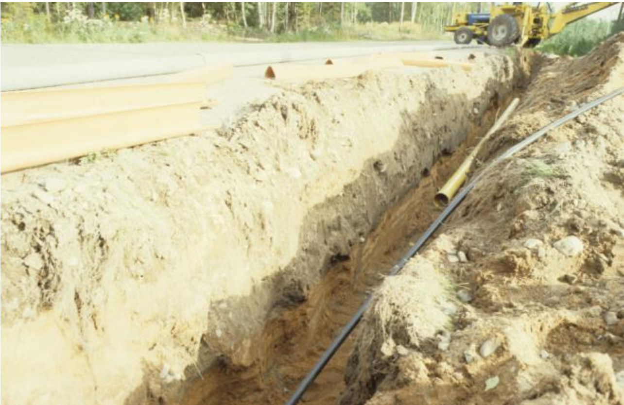
Kuva 22. Kaapelikaivanto maantieojassa Riihipellon kohdalla. Kuvattu pohjoisluoteeseen. (OY ark. lab. dia 6678)
