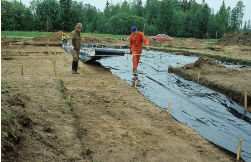
6106. Kaivausalueetta peitetään muovilla kesäloman ajaksi. Kuvattu etelälounaaseen.
