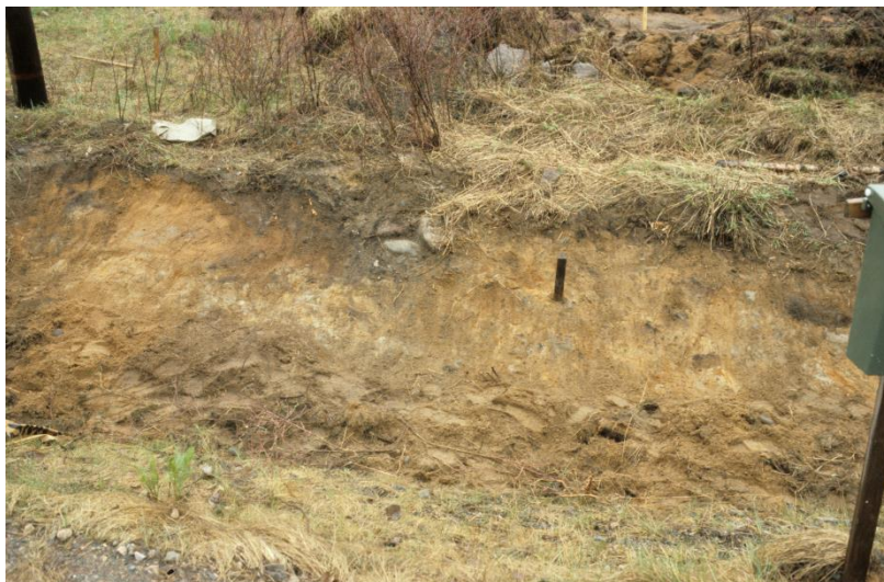
6410. Pajapelto: maantieleikkausn pohjoispää. Kuvattu kaakkoon.
