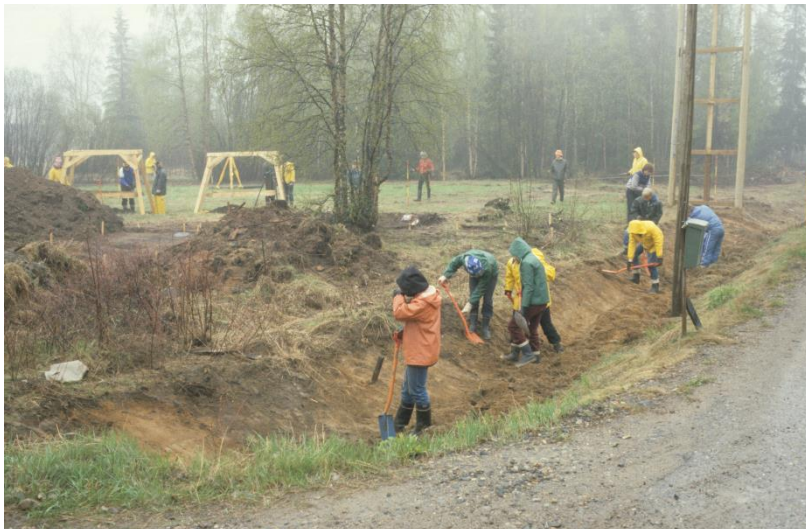
6409. Pajapellon maantieluiskan leikkausn kaivu käynnissä. Kuvattu etelään.
