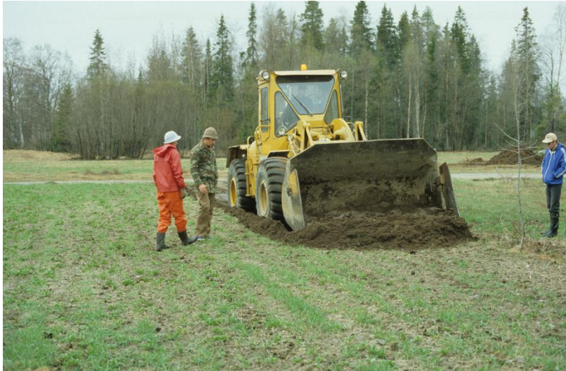
5931. Kauhakuormaaja poistamassa peltomaata ns. läntisessä koneurassa. Työtä valvovat Pentti Koivunen ja Toini Kemppainen.
