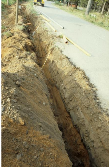
6420. Pajapelto: maantieojan kaapelikaivanto. Kuvattu Uiton parakkiin menevältä tieltä etelälounaaseen.
