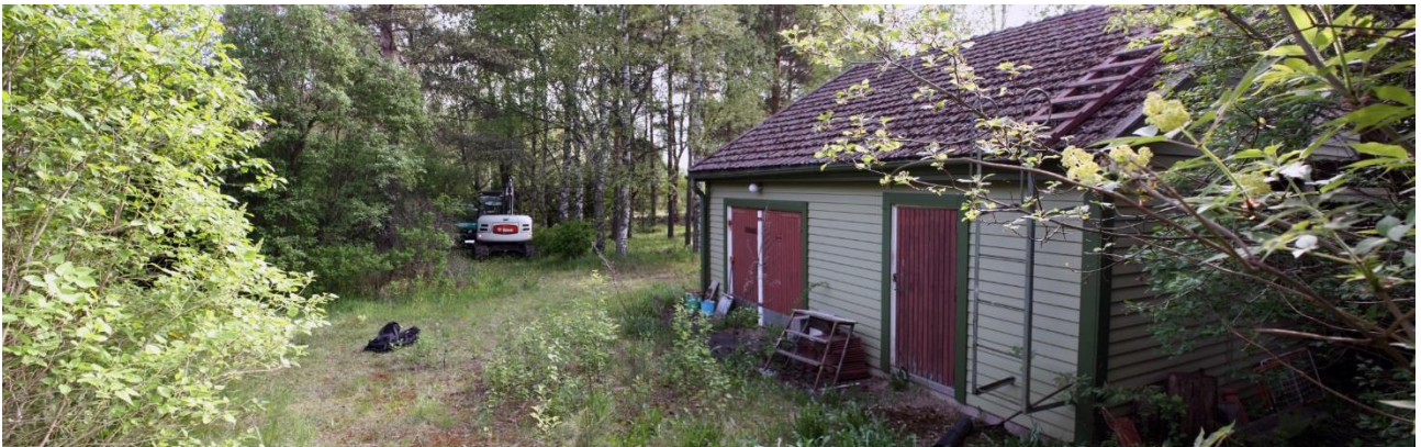
Kuva 4. Tutkimuskohteena oleva pihapiiri, kuvattu lounaasta. AKDG 4726:4
