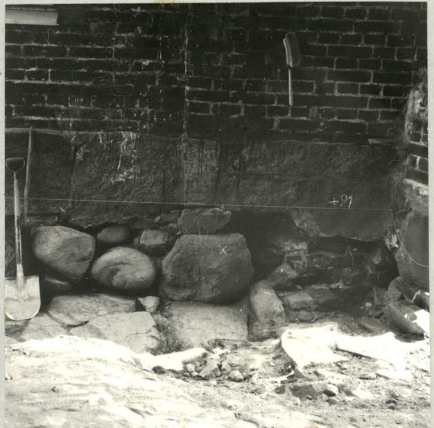
B-OSA, TIILIMUURI KIVIJALAN SISÄLLÄ OIKEALLA (KIVIJALAN ALUEUNASSA)
