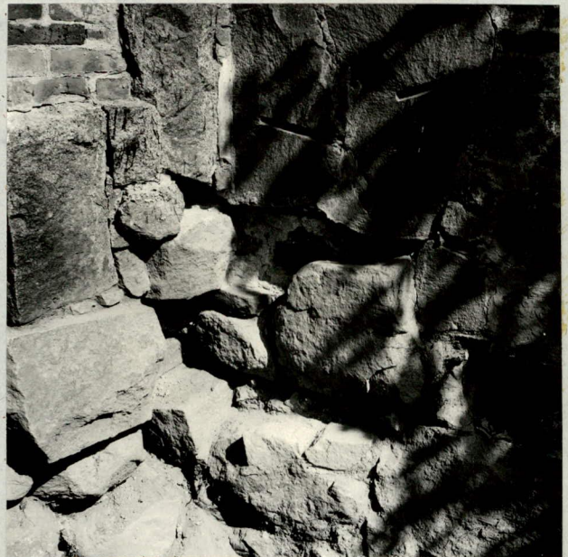
A-KUOPPA, PORTIN KOHTA TIILIMUURI KIVIJALAN SISÄLLÄ
