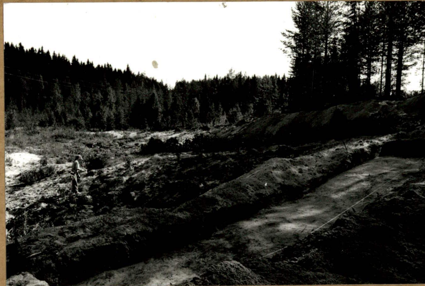
KUVA 7 F. 106958 YLEISKUVA HIEKKA KUOPAN LÄNSIREUNASTA JA TASOKAI- VAUSALUEET, KUVATTU LUOTTEESTA.
