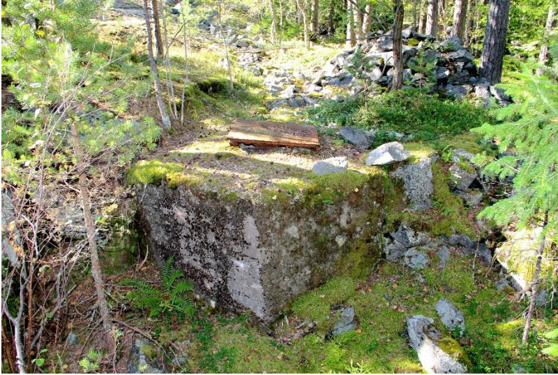
AKDG 4877:154. Itä-Villinki, kaapelikaivo. Kuvaaja: J. Lagerstedt.
