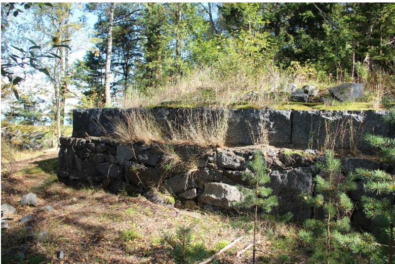
AKDG 4877:160. Itä-Villinki, rakennuksen perusta. Kuvaaja: J. Lagerstedt.
