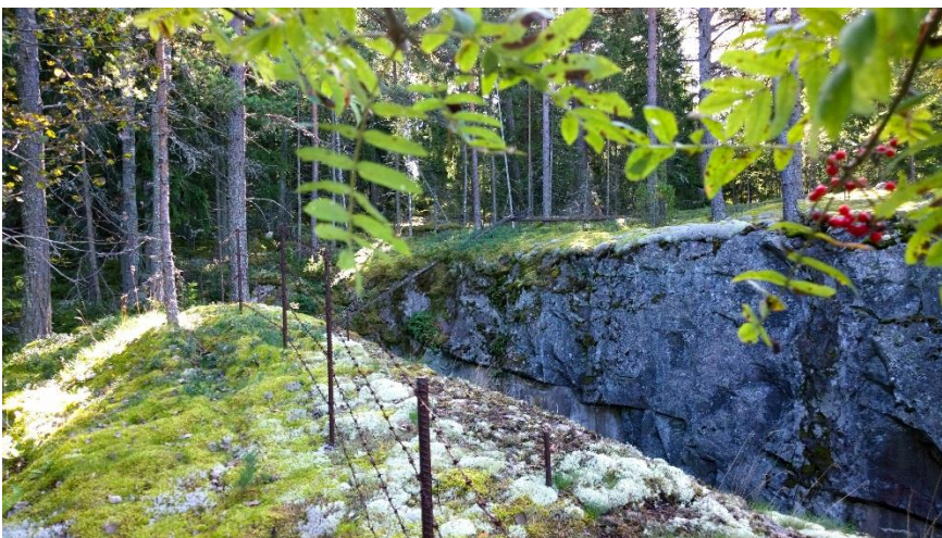
AKDG 4877:87. Itä-Villinki, varuskunnan suojatunnelit. Kuvaaja: S. Koivisto.
