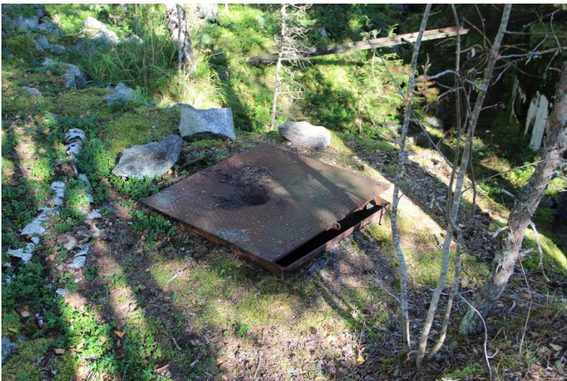
AKDG 4877:157. Itä-Villinki, kaapelikaivo. Kuvaaja: J. Lagerstedt.
