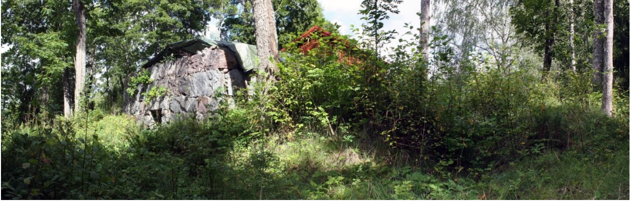
Kuva 24. Oikealla maakellarikuoppa ja vasemmalla holvirakenteinen maakellari, kuvattu lounaasta. AKDG 4878:18
