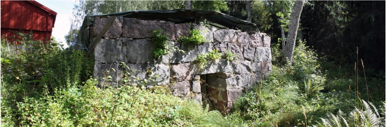
Kuva 25. Holvirakenteinen maakellari, kuvattu lännestä. AKDG 4878:21
