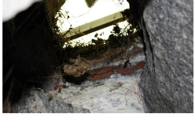
Kuva 30. Maakellarin katossa oleva aukko, jonka rakenteessa on käytetty tiiliskiviä, kuvattu idästä. AKDG 4878:26
