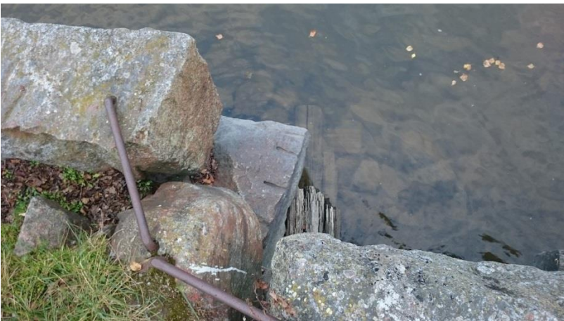
Kuva 3. Lähikuvassa harkkokivien alta pilkottavia rikkoutuneita hirsiiä. Kiviä on kiinnitetty toisiinsa rautatangoin. Kuvaussuunta koilliseen.
