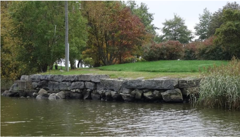
Kuva 2. Räättälinsaaren koillisosan harkkokivipengerrystä. Pengerrys on perustettu hirsiarkuille. Kuvaussuunta lounaaseen.
