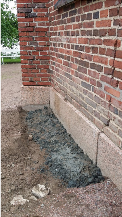
Kuva 16: MuTu116003Dg_026. Koekuoppa 3, palautettu savivaip- pa. SE. Kuva: J.L.
