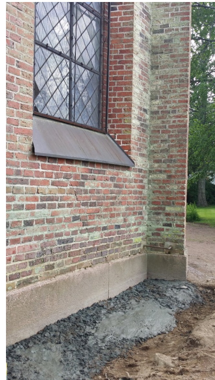
Kuva 8: MuTu116003Dg_012. Koe-kuoppa 2, palautettu savivaippa. N. Kuva: J.L.
