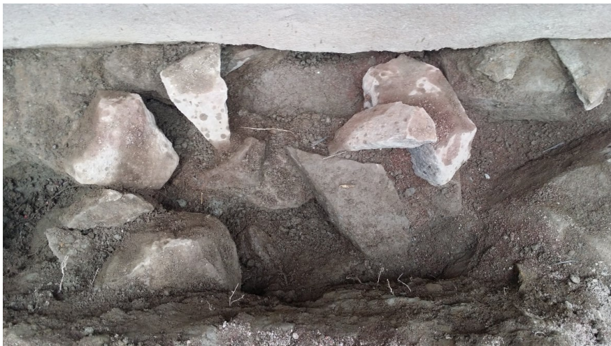
Kuva 15: MuTu116003Dg_025. Koekuoppa 3, seinän alta puuttuvat kivet, kuva yläpuolelta. Kuva: J. L.
