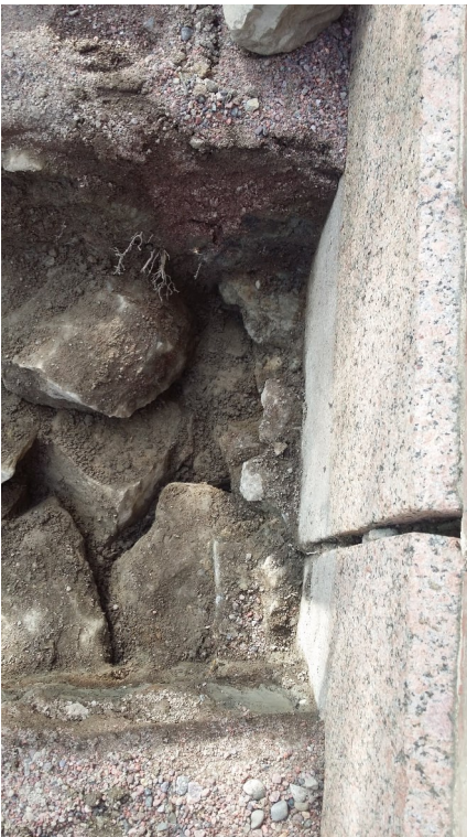
Kuva 11: MuTu116003Dg_016. Koekuoppa 3, ensimmäinen kaivanto ylhäältä kuvattuna. S. Kuva: J. L.
