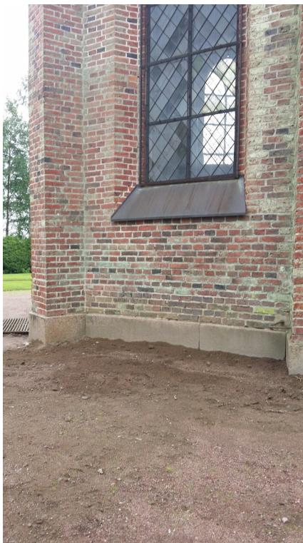
Kuva 18: MuTu116003Dg_014. Koekuoppa 2, peitetty kaivanto. N. Kuva: J.L.
