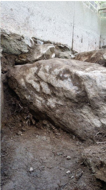
Kuva 7: MuTu116003Dg_010. Koe-kuoppa 2, lähikuva kiviarinan ja seinän liitoksesta. N. Kuva: J.L.
