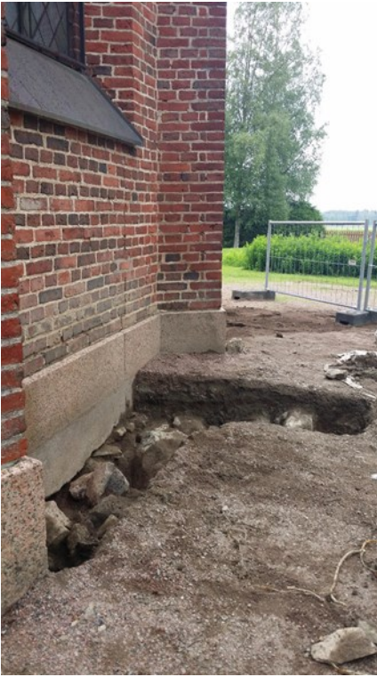
Kuva 9: MuTu116003Dg_020. Koekuoppa 3. SW. Kuva: J.L.
