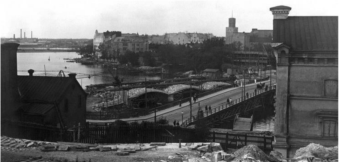
Kuva 6. Puinen pitkäsilta ja taustalla uuden kivisillan rakentaminen vuonna 1912. Kuva: Helsingin kaupunginmuseo, N252154. Kuvaaja: tuntematon.
