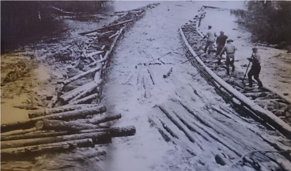
Kuva 2. Uittorakenteita Vietsinjoen Kuurtajankoskessa 1950-luvulla. Inventoinnissa Suituan uomassa havaittiin samantyyppisiä hirsiaurakenteita. Kuvälähde: Wilmi 2003, 352. Kuvaaja Toivo Väisänen.
