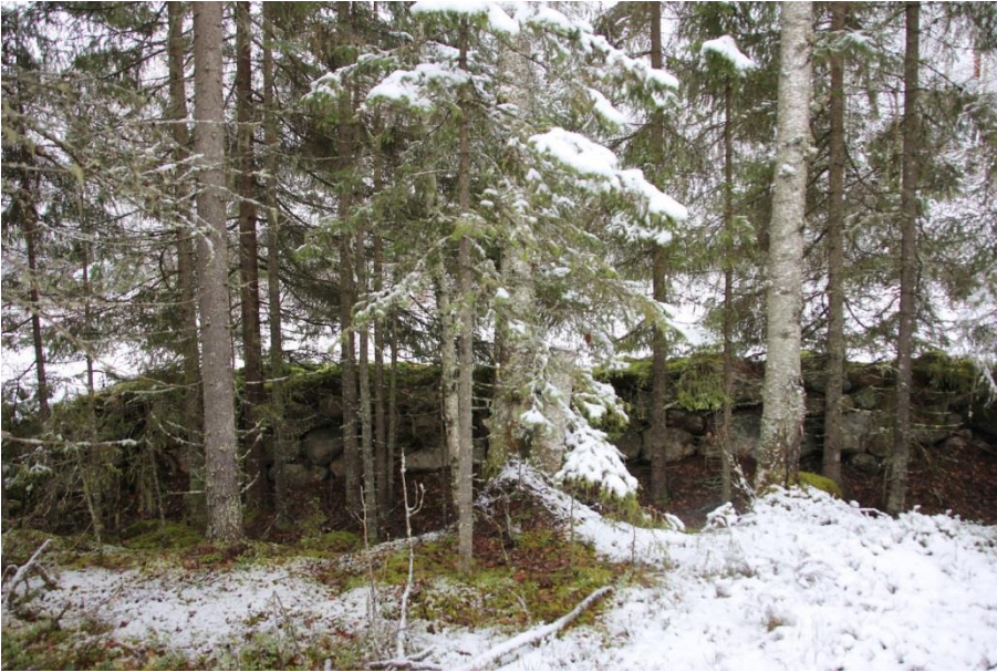
Kuva 18. Suituan vetomöljä on korkeimmillaan alajuoksulla. Kiviladella on tehty ilman hirsirakenteita. Tämän korkeimman ja massiivisimman rakenteen pituus on noin 275 metriä.
