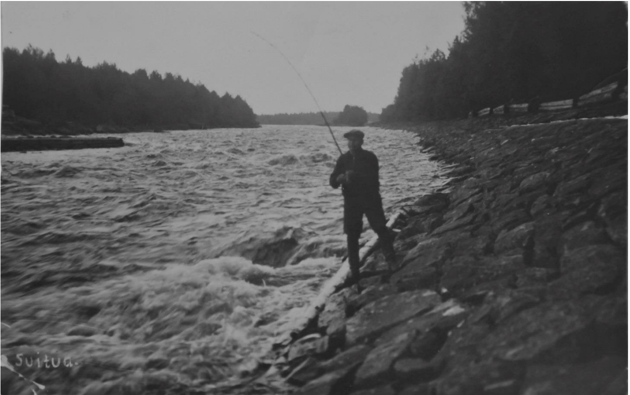
Kuva 16. Kalastaja Suituan kivisuisteella. Suisteen yläosassa näkyy hirsillä etureunastaan tuettu vetomöljä. Vasemmalla uomassa näkyy hirsiarkkurakenteinen pohjapato tukinuittoa helpottamassa. Kuvattu ennen vuotta 1950, jolloin Katerman voimalaitoksen valmistuminen kuivatti uoman. Kainuun museon kuvakokoelma K-6080:10.
