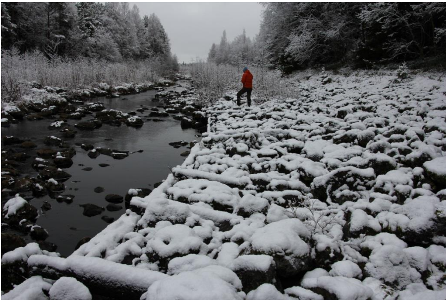
Kuva 20. Suituan uoman pohjapadosta on jäljellä vain alimmat rakenteet. Pato on hirsiiarkkurateinen. Kuvaussuunta kaakkoon.
