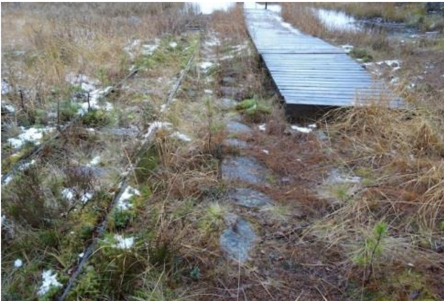
Kuva 10. Raiteet ja laituri on perustettu kiviladonnan päälle soistuvan maan vuoksi.
