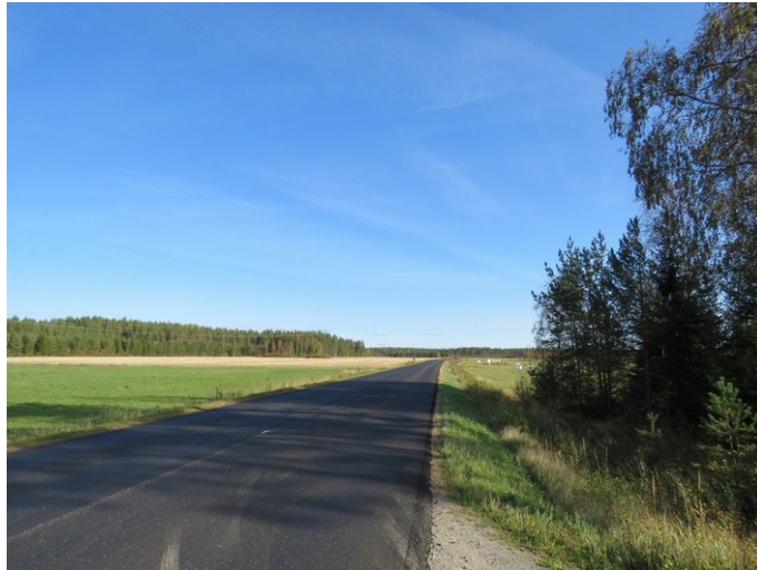
Kuva 13. Sähkösiirtolinjaus paikallistien no. 714 vieressä. Kuvattu kaakkoon.
