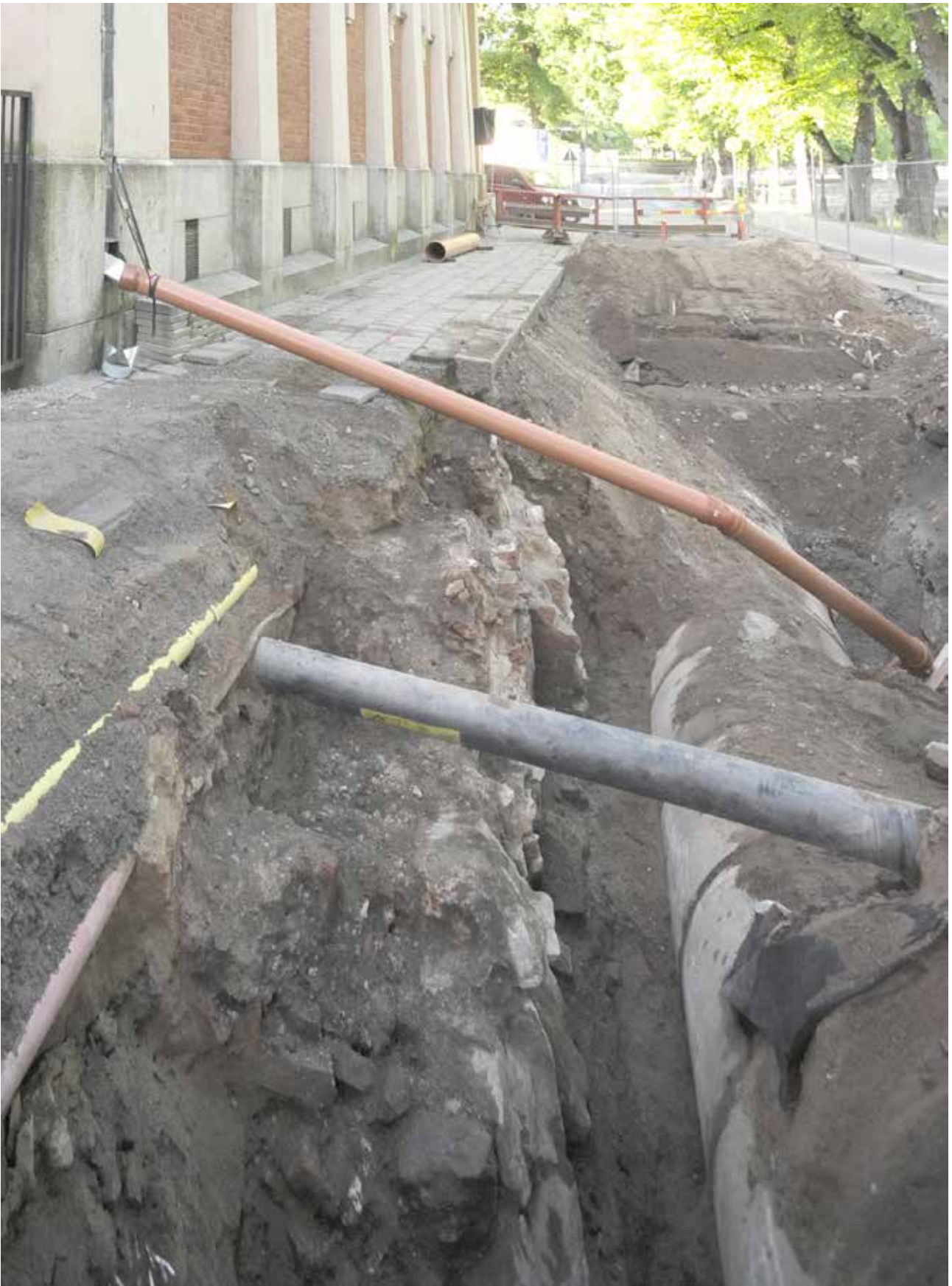
DT2016:74:4. Putkikaivannosta esiin tulleet rauniot puhdistettuna. N. KU. Toukokuu 2016.
