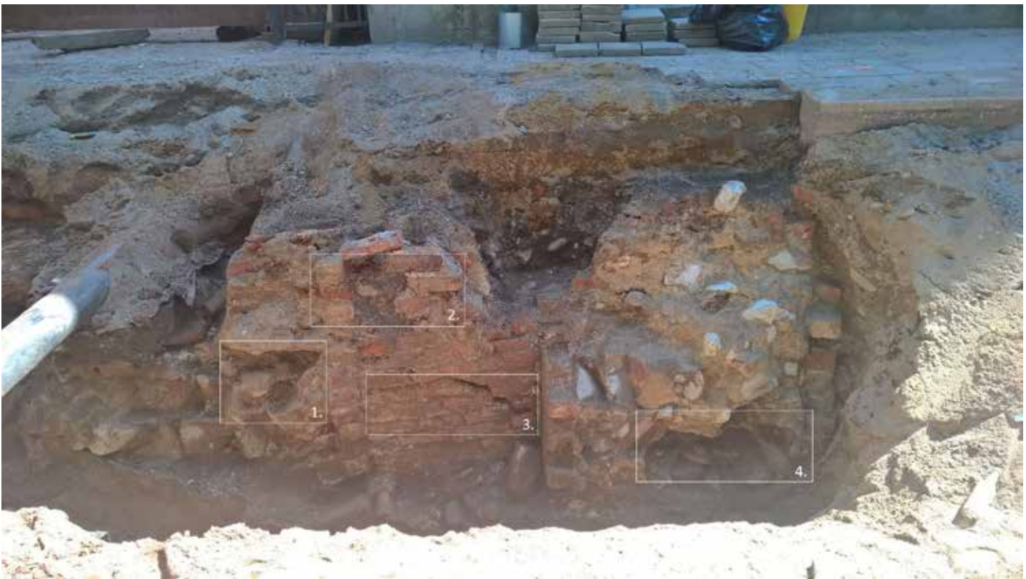
Karttakuva 2. Muurirakenne puhdistettuna ennen korjaustöitä. KU: W. Toukokuu 2016. Kuvan lisäykset J. Lehtola / Muuritutkimus ky
