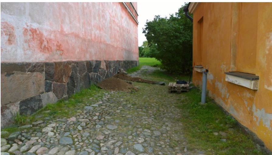
AKDG 4903:15. Koekuopan 3 sijainti talojen välissä, koillisesta. Kuvaaja: Petro Pesonen.
