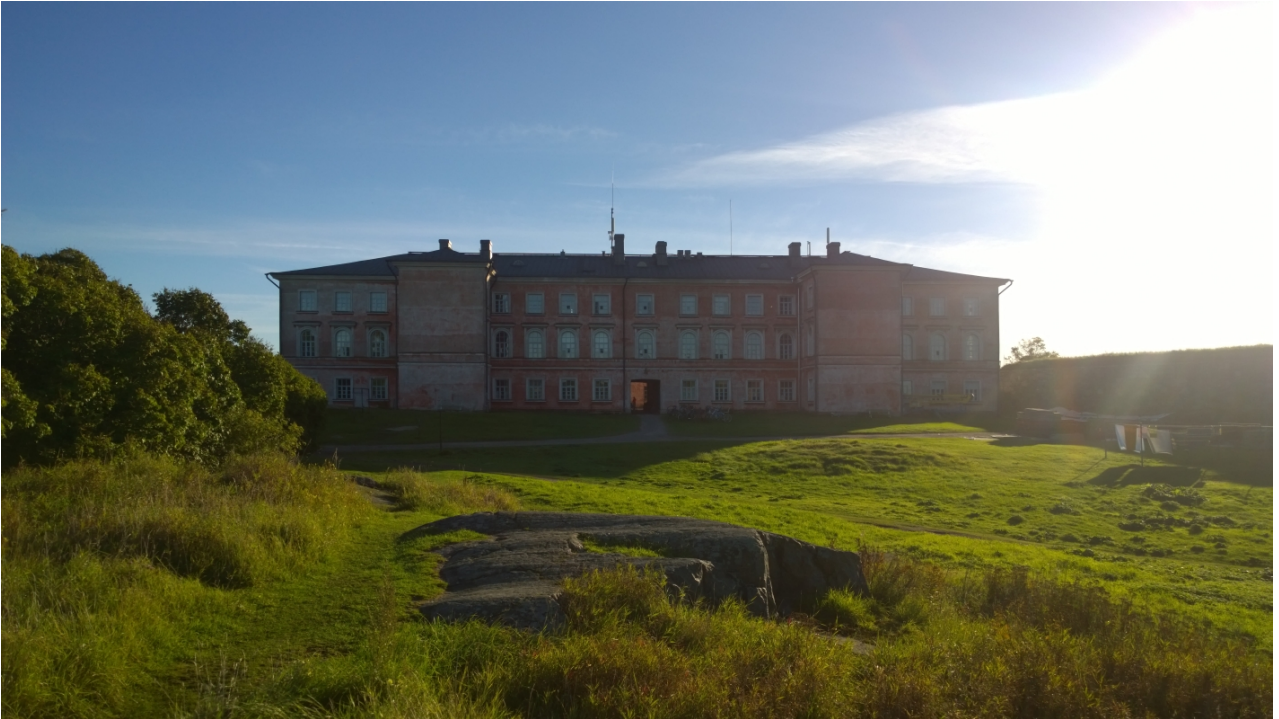
AKDG 4903:1. Vaasan kasarmi, rakennus C83, lännestä. Kuvaaja: Petro Pesonen.
