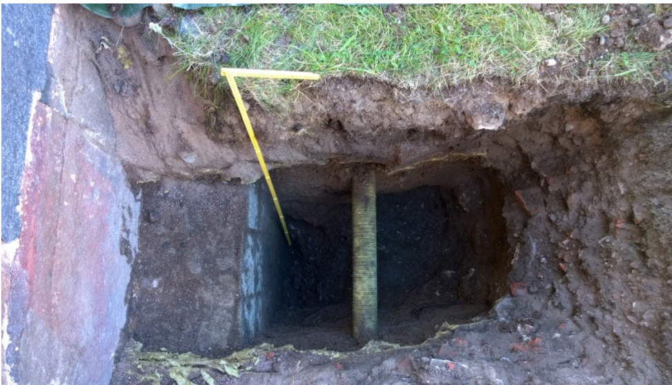
AKDG 4903:25. Koe- kuoppa 5 pohjassa, luoteesta. Kuvaaja: Petro Pesonen.
