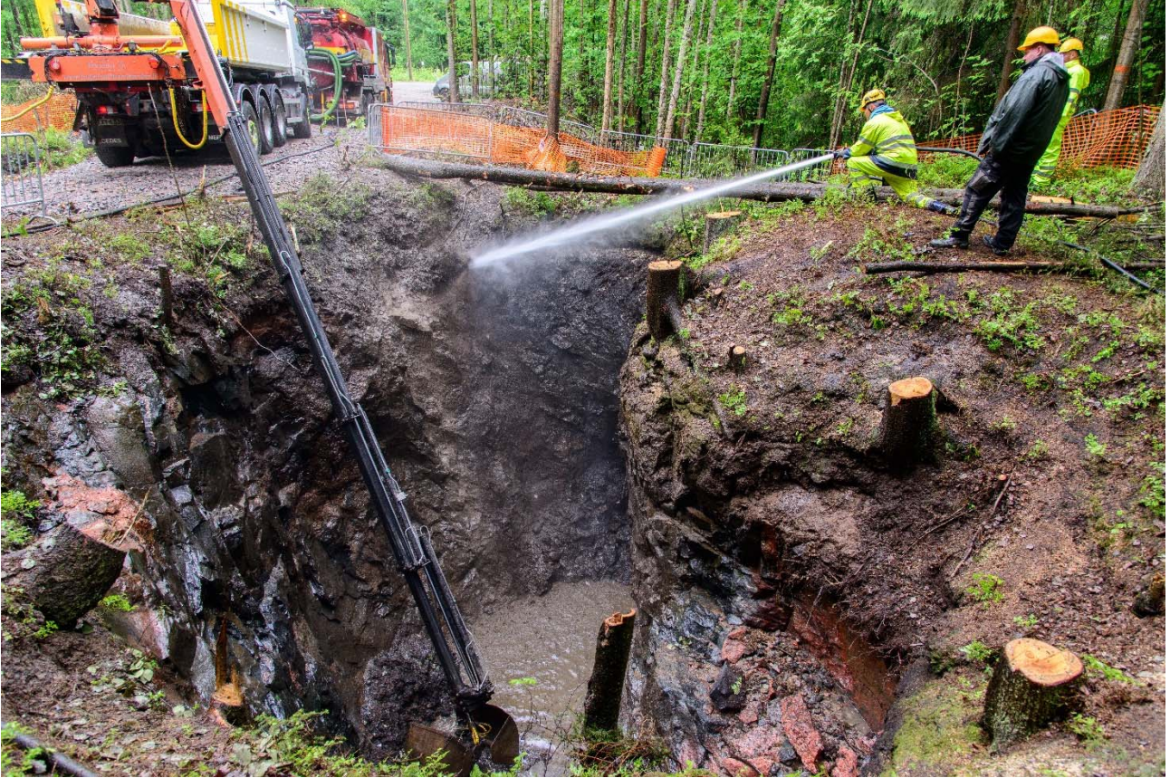
Kuva 4. Suuren kaivoskuopan reunoihin tarttunutta maata poistetaan painesuihkulla. Kuva: Vesa Laulumaa/ARKE (AKDG4910:13).
