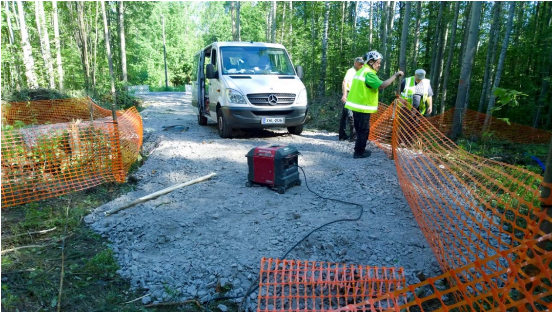
AKDG4910:1. Kaivosmontuille rakennettu kulkuväylä ja työmaa-aitaus. Suurimman kuopan pumppaus alkamassa. Kuva etelästä. (Kuva Satu Koivisto)
