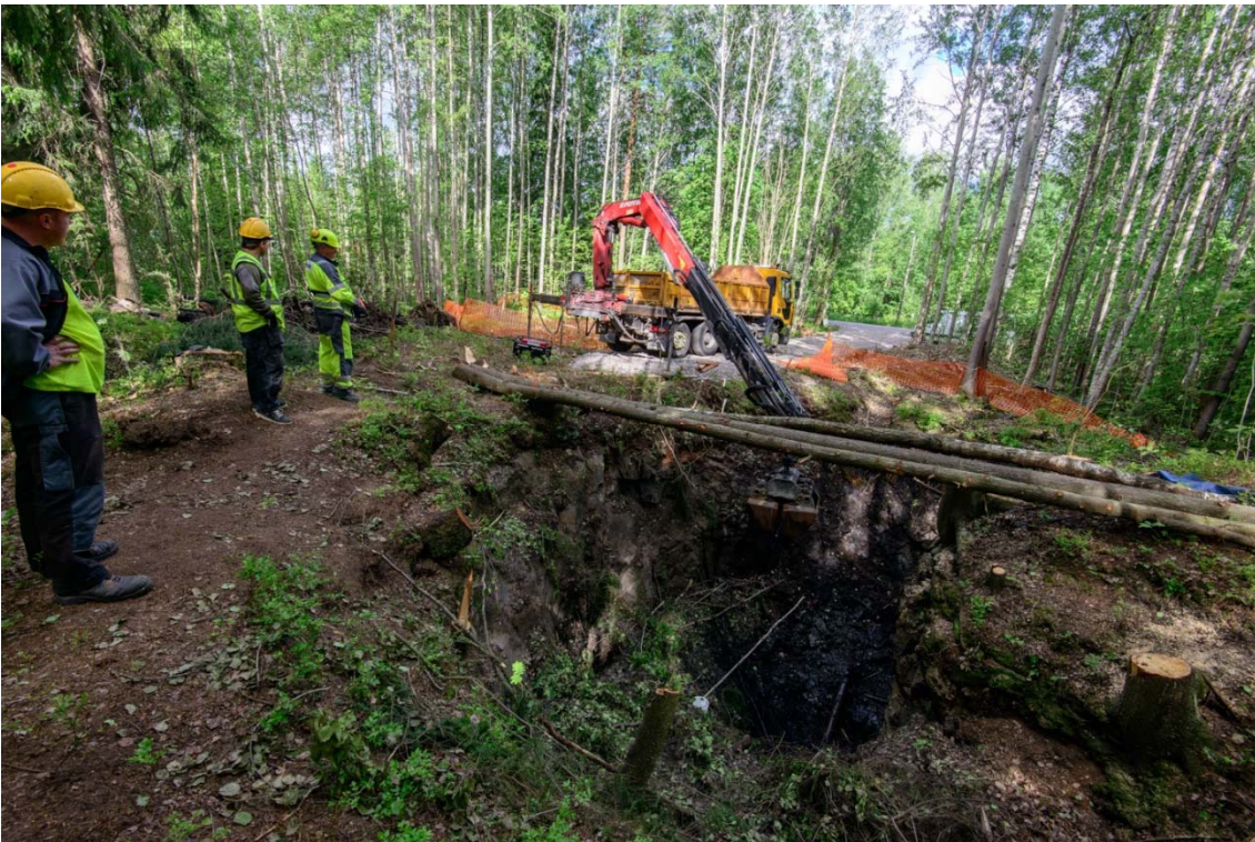
AKDG4910:6. Suuren kaivoskuopan tyhjennys käynnissä. (Kuva Vesa Laulumaa)
