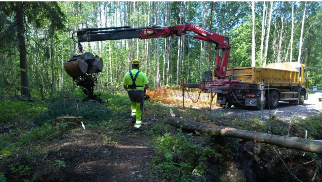
AKDG4910:4. Kariketta ja liejua poistetaan suuresta kaivoskuopasta kauko-ohjattavalla kouralla. (Kuva Satu Koivisto)
