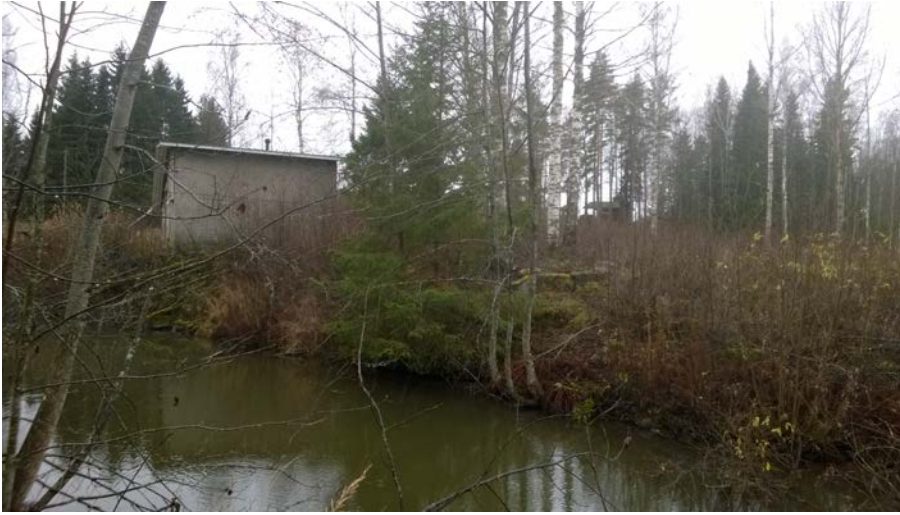
AKDG 5043:101. Sahajärven saha ja mylly. Sahan alueen länsipuolta, taustalla leikkimökki sahan länsipuolisen tontin paikalla, koillisesta. Kuvaaja: Tuija Väisänen.
