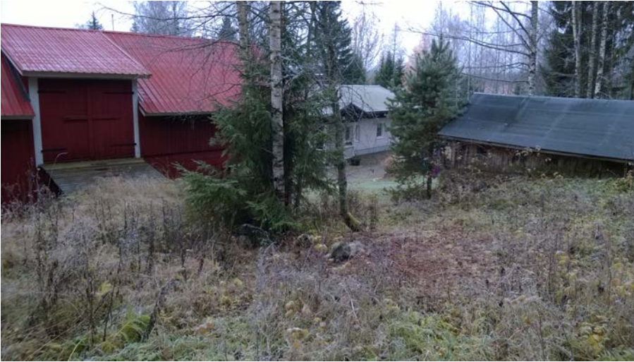
AKDG 5043:51. Rantalan torppa. Etu-Rantalan pihapiiriä, pohjoisesta. Kuvaaja: Tuija Väisänen.
