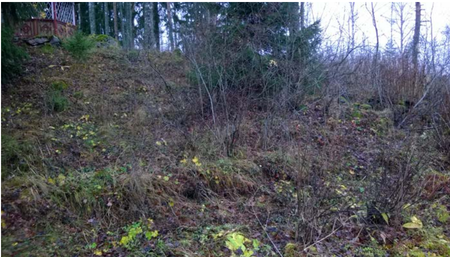
AKDG 5043:105. Sahajärven saha ja mylly. Kiviseinäinen kellari ja kivijalkaa kuvan oikeassa reunassa sahan länsipuolisella tonttialueella, lounaasta. Kuvaaja: Tuija Väisänen.
