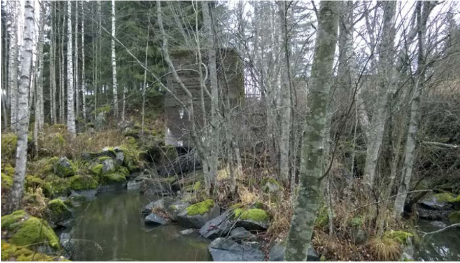
AKDG 5043:98. Sahajärven saha ja mylly. Sahaan liittyviä eri aikaisia rakenteita nykyisten rakennusten ja sillan eteläpuolella, etelästä. Kuvaaja: Tuija Väisänen.
