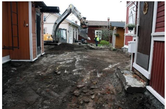
Kuva 13. Pintamaan alta paljastunut kalliopinta Hakunin tontin asuinrakennuksien välissä, kuvattu idästä. AKDG 5118:11
