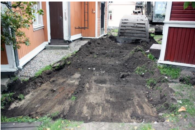
Kuva 12. Pintamaata poistetaan Hakunin tontin asuinrakennuksien välistä, kuvattu idästä. AKDG 5118:9
