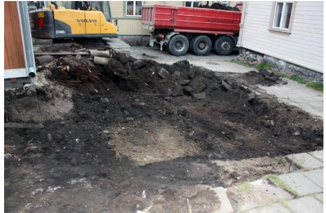
Kuva 11. Pintamaata poistetaan Hakunin tontille johtavan ajotien kohdalta, kuvattu pohjoisesta. AKDG 5118:8
