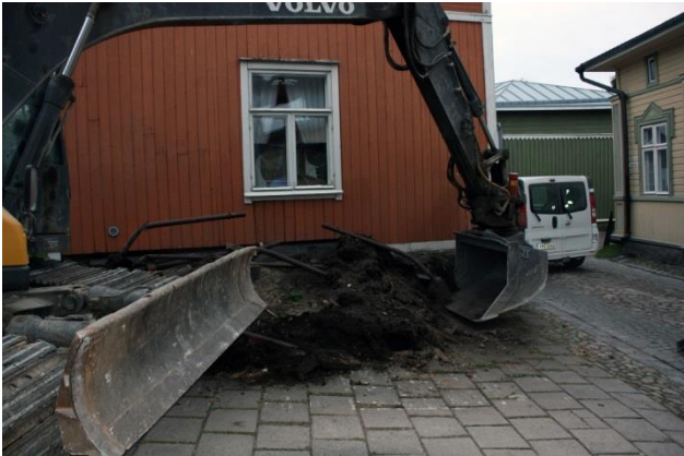
Kuva 10. Pintamaata poistetaan Hakunin tontin kadunpuoleisen asuinrakennuksen länsipäädyn edustalta, kuvattu lännestä. AKDG 5118:7
