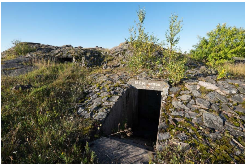
AKDG 4500:92. Isosaari 43. Meri-patteri 1944 sisäänkäynti. Kuva koillisesta. Kuvaaja: V. Laulumaa.
