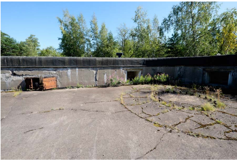
AKDG 4500:116. Tykkipatteri C. Tykin paikka ja ampumatarvikekomerot. Kuva pohjoisesta. Kuvaaja: V. Laulumaa.
