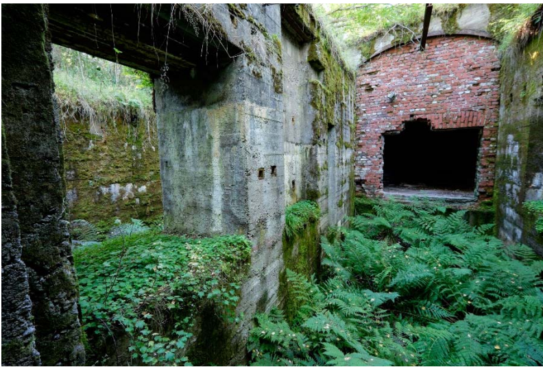
AKDG 4500:11. Isosaari 1. Keskussähköaseman idän puoleinen huone. Kuva pohjoisesta. Kuvaaja: V. Laulumaa.
