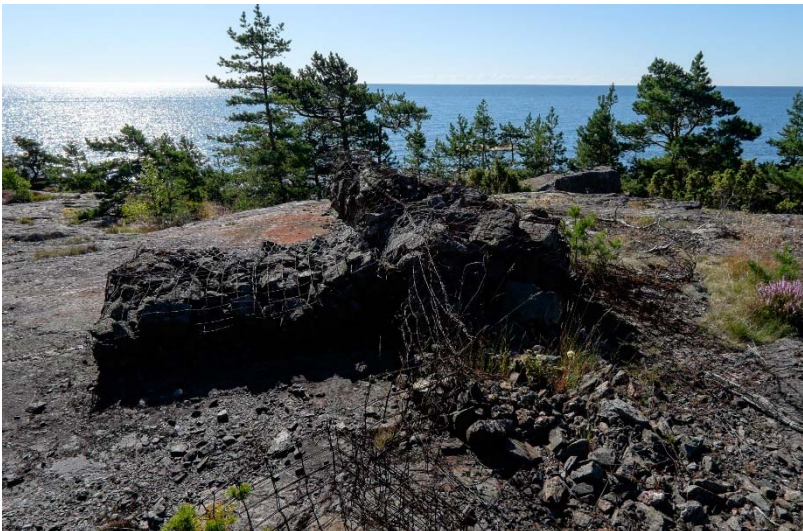
AKDG 4500:68. Isosaari 31. Kivistä kasattu ja rautalankaverkolla tuettu suoja rantakalliolla. Kuva pohjoisesta. Kuvaaja: V. Laulumaa.
