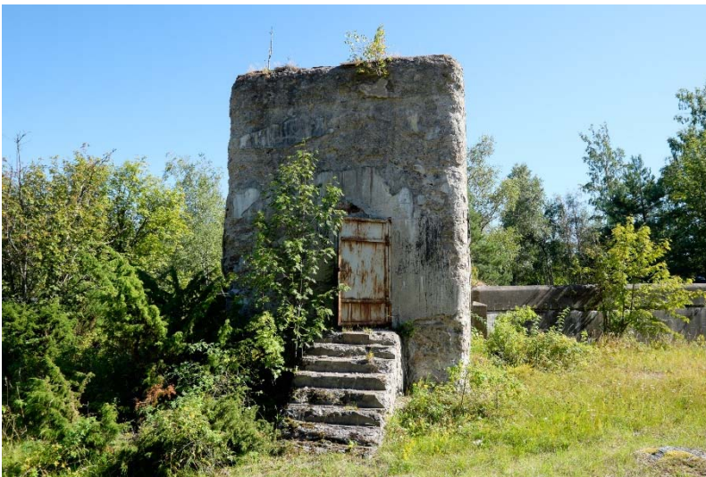
AKDG 4500:113. Tulenjohtotornin sisäänkäynti tykkipatterin C kohdalla. Kuva pohjoisesta. Kuvaaja: V. Laulumaa.
