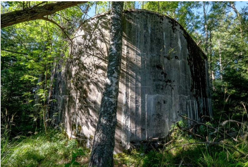
AKDG 4500:3. Isosaari 1. Valonheitinaseman pohjoisseinä. Kuva etelästä. Kuvaaja: V. Laulumaa.
