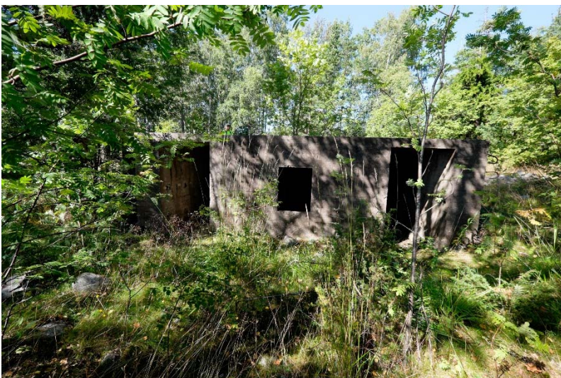
AKDG 4500:84. Isosaari 35. Betonista tehty rakennus. Kuva pohjoisesta. Kuvaaja: V. Laulumaa.
