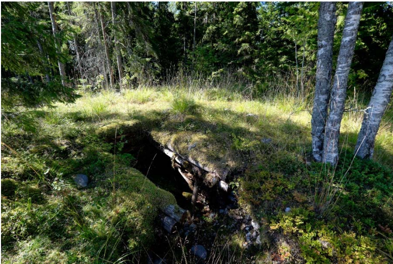
AKDG 4500:49. Isosaari 18. Parissa tulasemassa on säilynyt vielä hirsirakenteita. Kuva idästä. Kuvaaja: V. Laulumaa.
