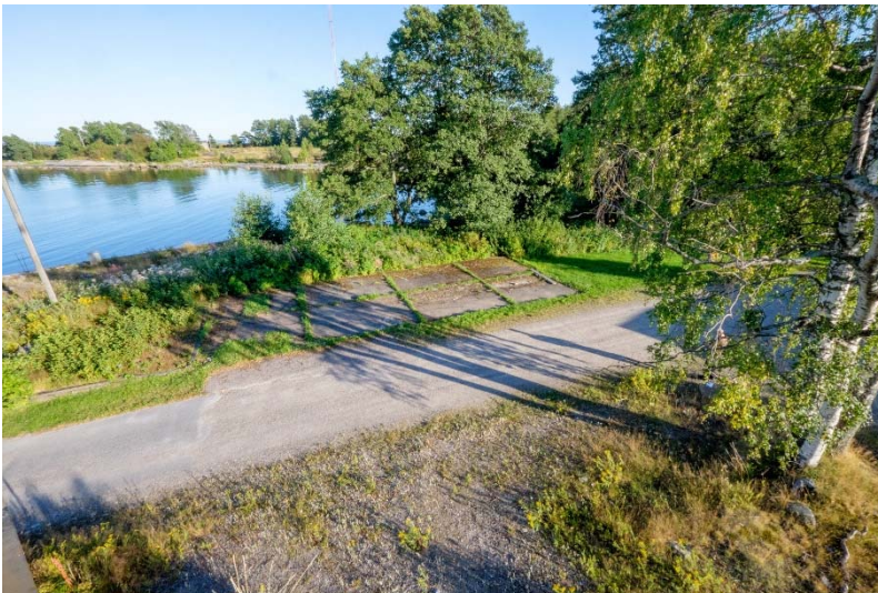
AKDG 4500:59. Isosaari 27. Veturitalin pohjan betonilaatat tien vieressä. Kuva luoteesta. Kuvaaja: V. Laulumaa.
