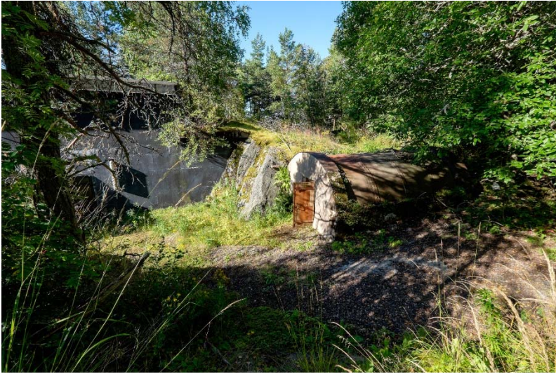
AKDG 4500:13. Isosaari 1. Polttoainesäiliön suojarakennus. Kuva koillisesta. Kuvaaja: V. Laulumaa.
