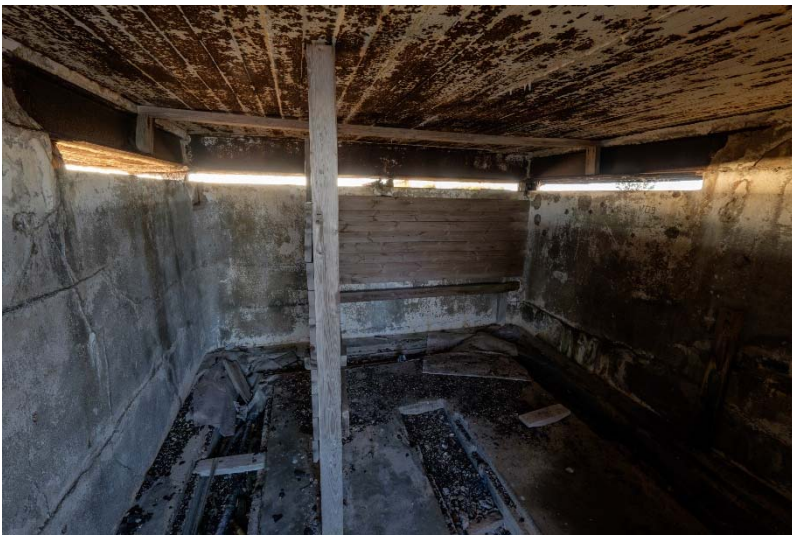
AKDG 4500:32. Isosaari 7. Etäisyysmittaustorni sisältä. Kuvaaja: V. Laulumaa.
