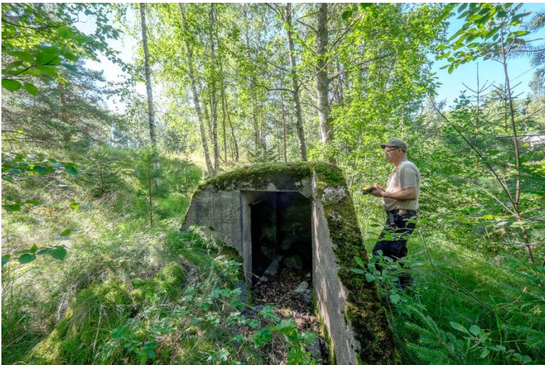
AKDG 4500:108. Tykkipatteri B. Muuntoaseman? suojakasematti päätien varressa. Kuva koillisesta. Kuvaaja: P. Pesonen.
