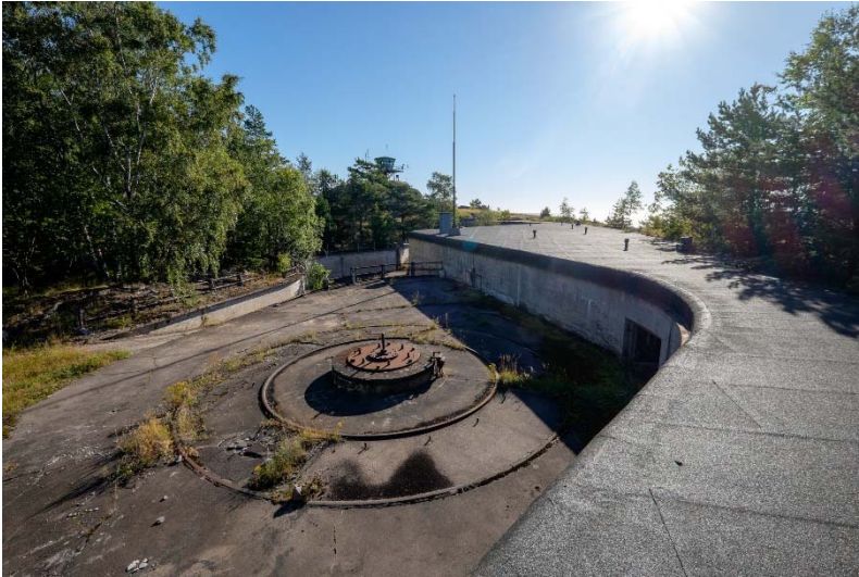
AKDG 4500:100. Isosaari tykkipatteri A. Tykkipatterin A itäisin tykkiasema, kuva lännestä. Kuvaaja: V. Laulumaa.
