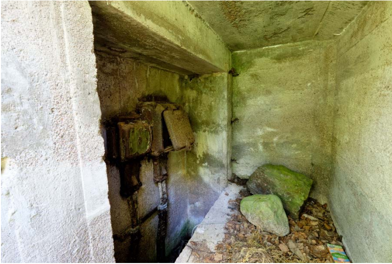
AKDG 4500:109. Tykkipatteri B. Muuntoseman? kasematti sisältä. Kuvaaja: V. Laulumaa.
