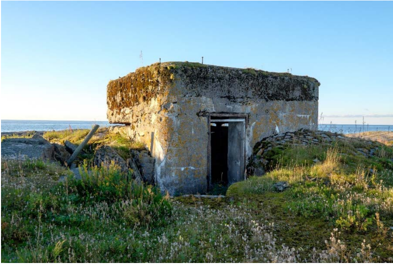
AKDG 4500:31. Isosaari 7. Etäisyysmittaustornin sisäänkäynti. Kuva koillisesta. Kuvaaja: V. Laulumaa.
