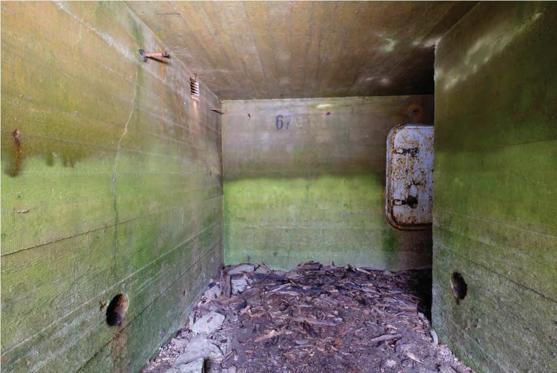
Kuva 14. Korsun sisäänkäynti. (AKDG4603:14)
