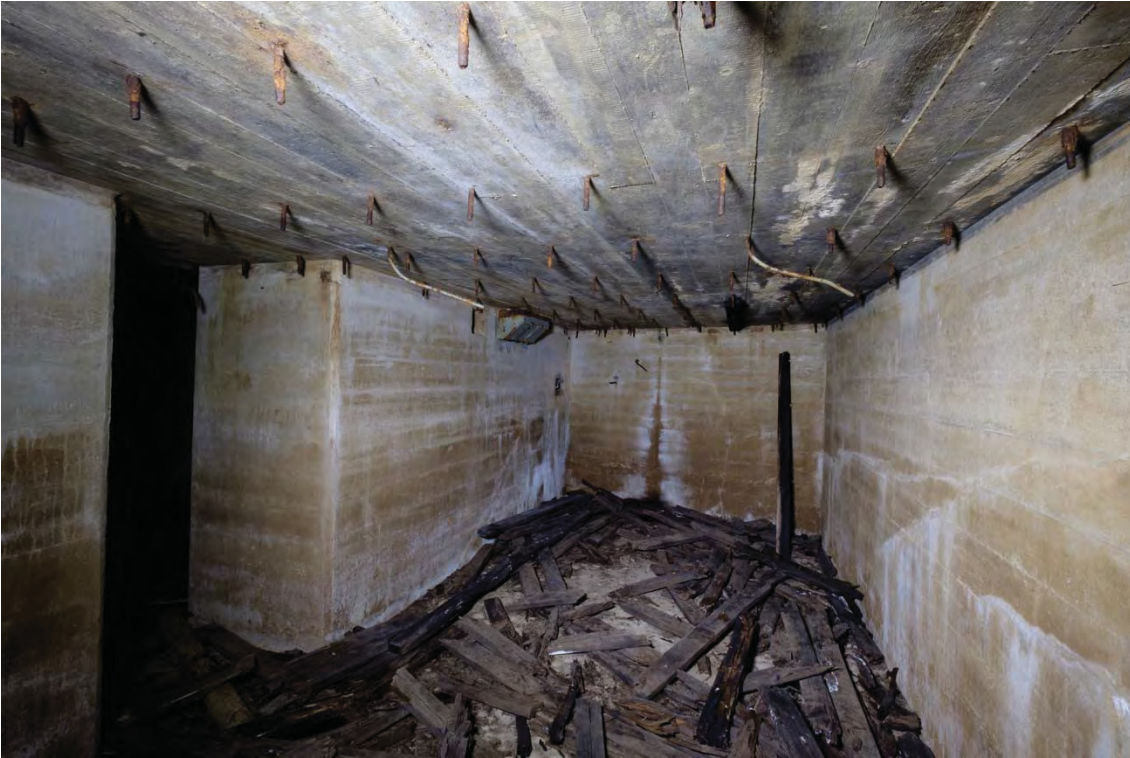
Kuva 11. Perimmäinen huone. (AKDG4603:11)
