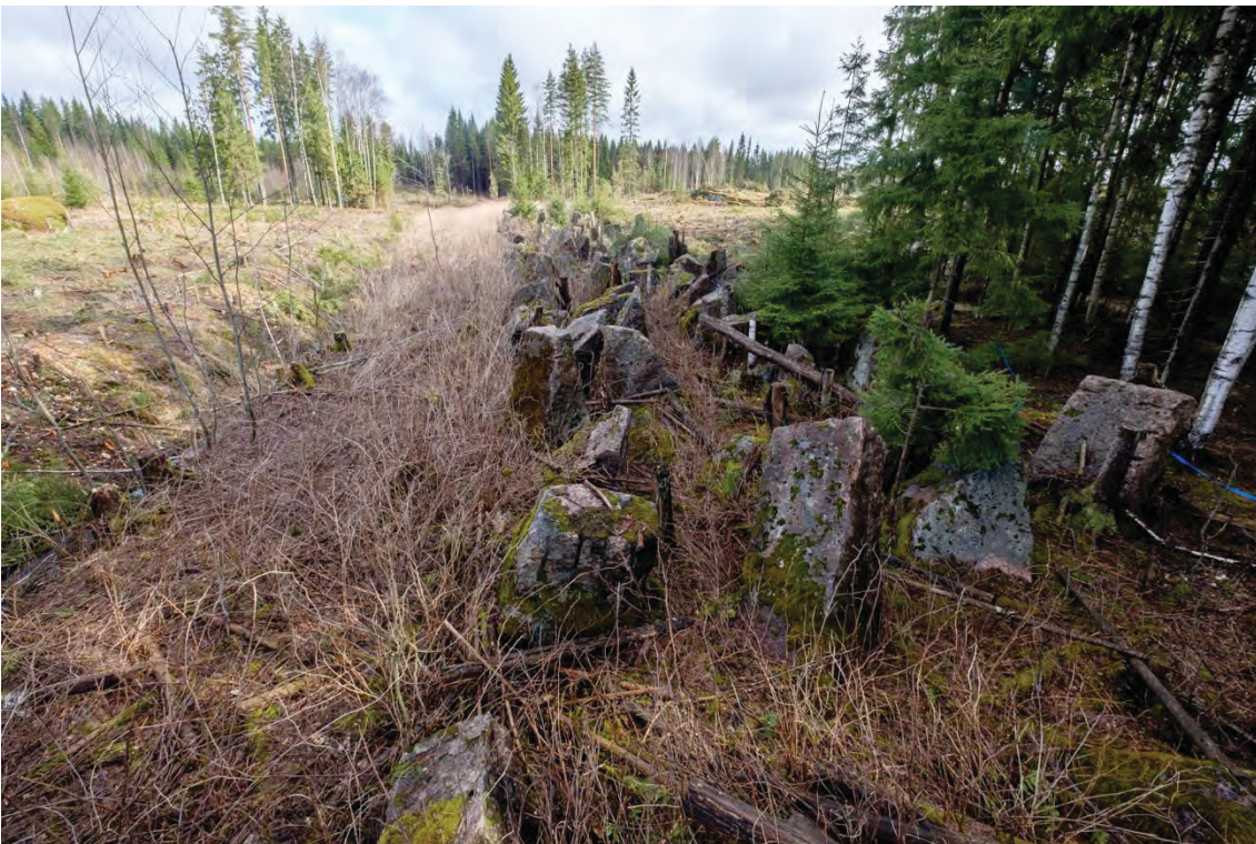
Kuva 29. Panssariestettä, kuva etelästä. (AKDG4603:29)
