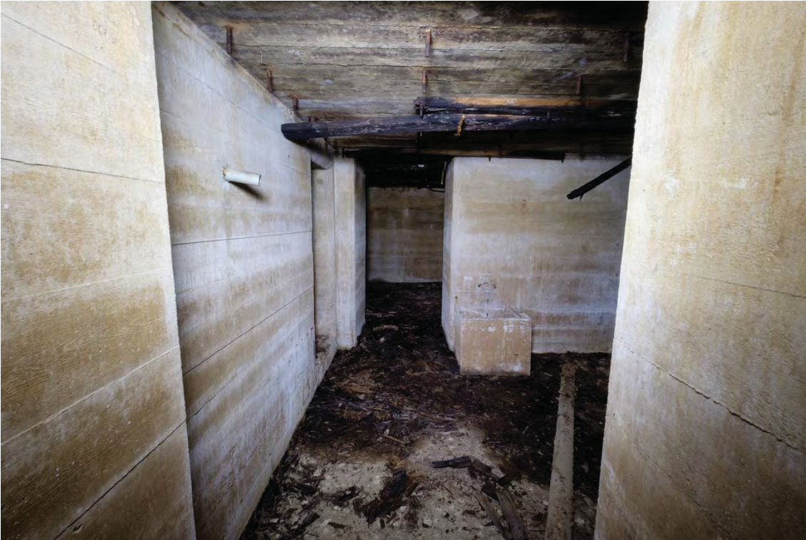
Kuva 18. Näkymä perimmäisen huoneen oviaukolta kohti ensimmäistä huonetta. Oikealla keittotilat ja vasemmalla kupukammion oviaukko. (AKDG4603:18)
