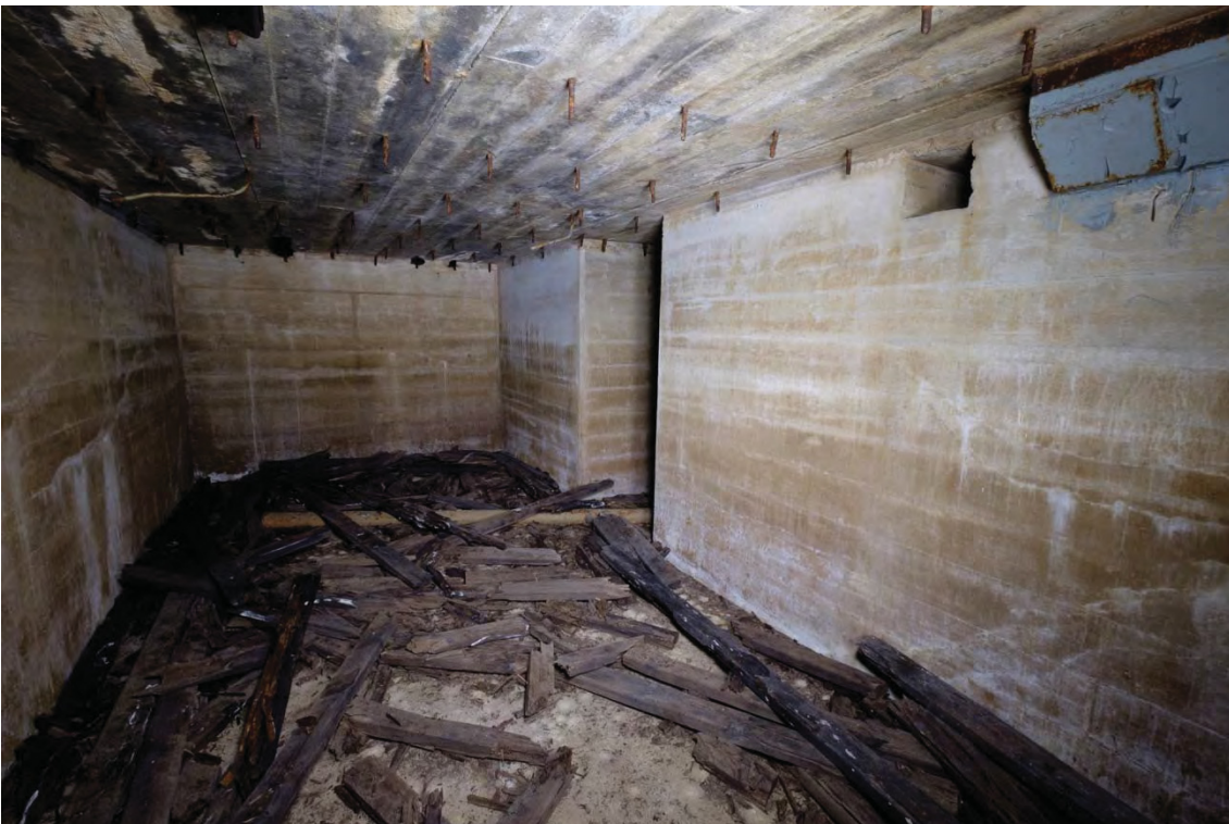
Kuva 19. Perimmäinen huone. (AKDG4603:19)
