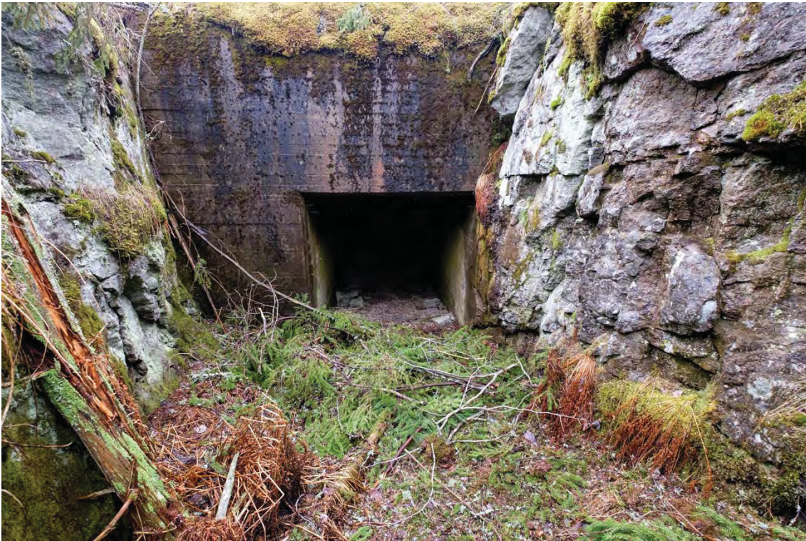
Kuva 2. Korsun 67 sisäänkäynti. (AKDG4603:2)
