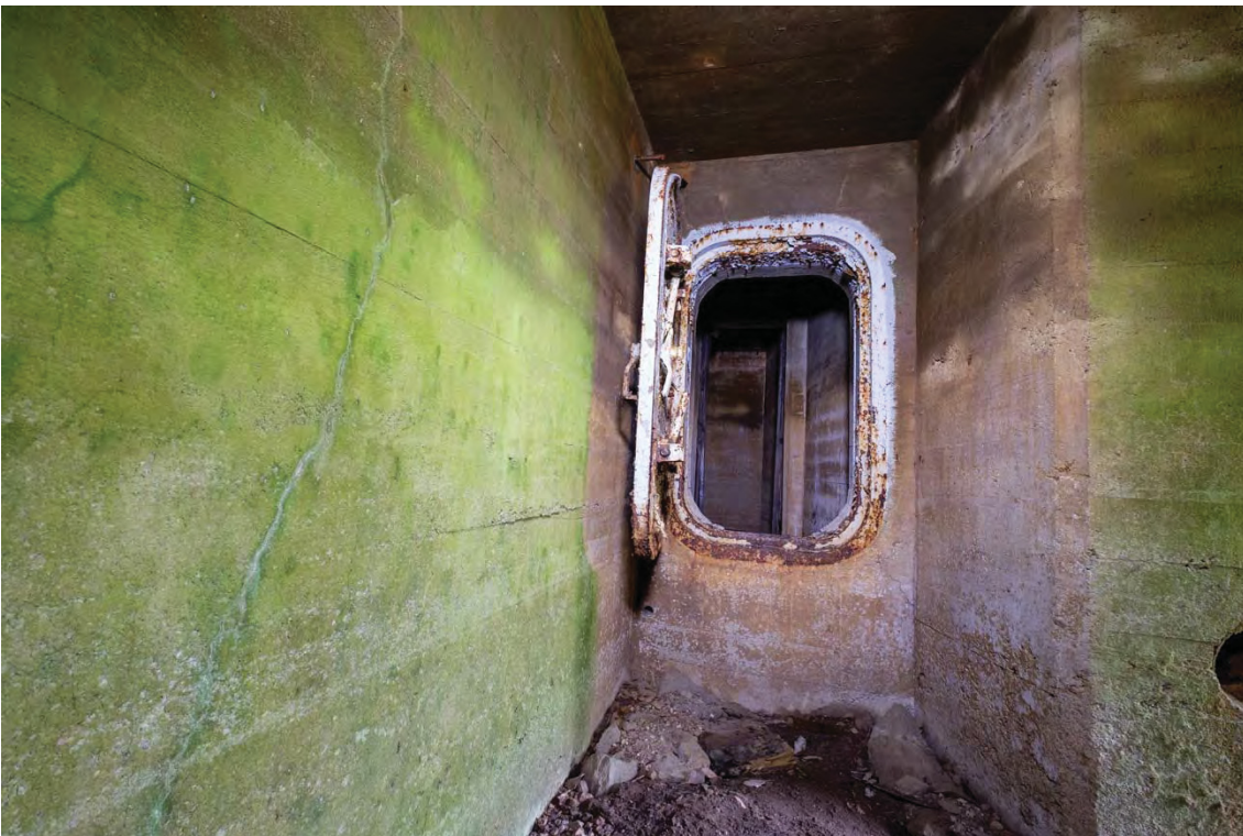
Kuva 6. Korsun sisäänkäynnin teräsovi. (AKDG4603:6)
