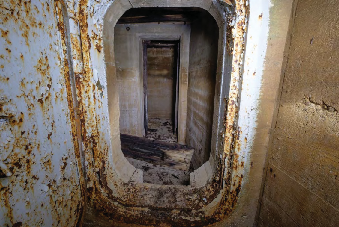
Kuva 7. Näkymä oviaukolta sulkuhuoneeseen. (AKDG4603:7)
