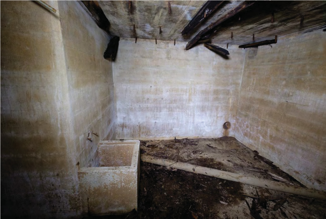
Kuva 16. "Keittiö", puuliesi on ollut oikeassa nurkassa, edessä vasemmalla vesisäiliö. (AKDG4603:16)
