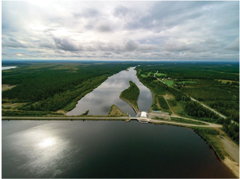
Kuva 1. Maisemaa Matarakosken voimalaitokselta etelään. (AKDG4891:1)
