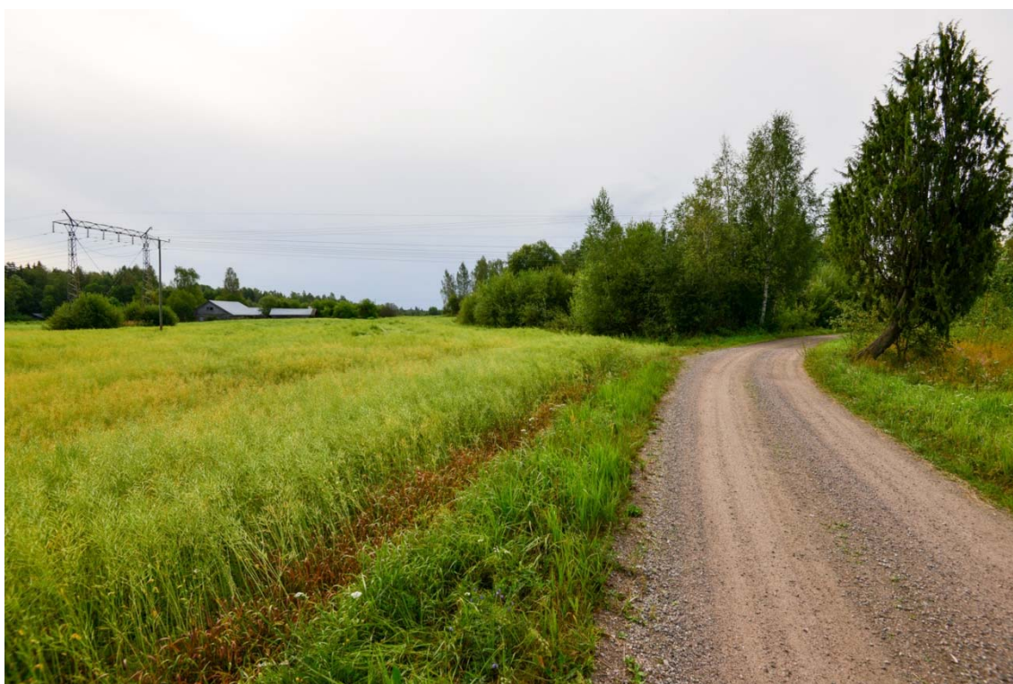
Luumäki Husula. Yhdyshauta päättyy tien vasemmalla puolella olevaan vesakkoon linjan alla. Kuva pohjoisesta. (AKDG3892:2)
