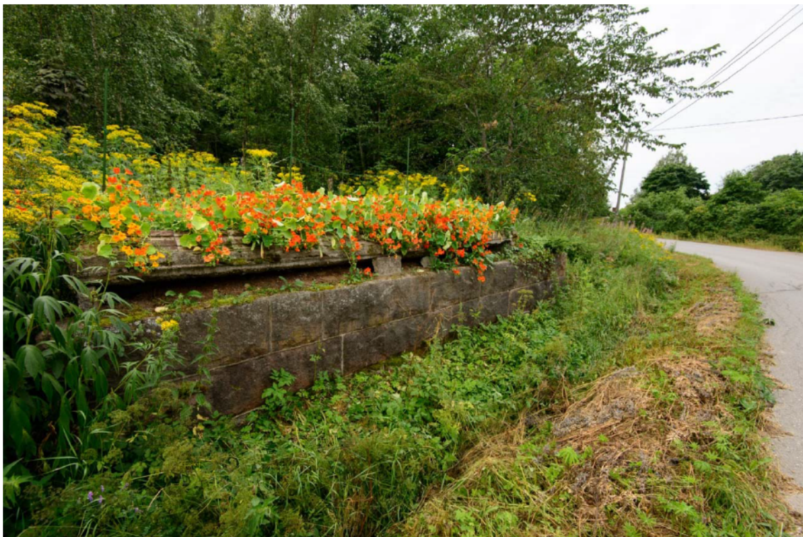
Pauni. 1800-luvun/1900-luvun alun rakennuksen kivijalka tien eteläpuolella. Kuvattu idästä. (DG3723:1)
