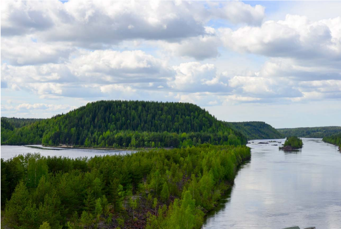
Kuva 2. Voimalaitoksen alapuolista jokea. Kuvassa korkeimmalle kohoaa Hyypiöniemen itäpäätä, joen keskelle on tehty pitkiä penkereitä. Kuva länteen voimalaitoksesta. (AKDG3728:3)
