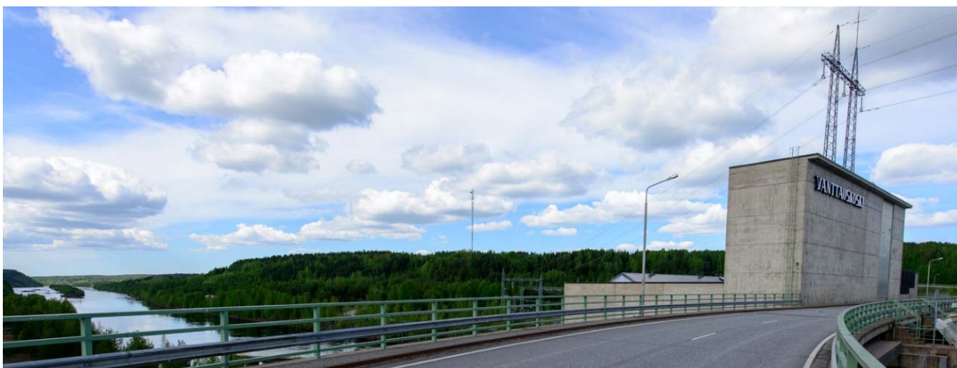
Kuva 1. Vanttauskosken voimalaitos ja sen alapuolinen Kemijoen juoksu. Kuva luoteeseen. (AKD3728:2)
