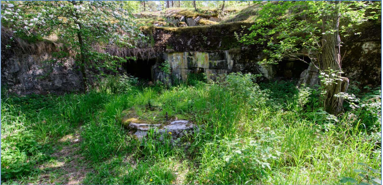
Tykkiasema ja betoninen tykinperusta patterissa nro 65. Kuva: Museovirasto, Vesa Laulumaa 2014.
