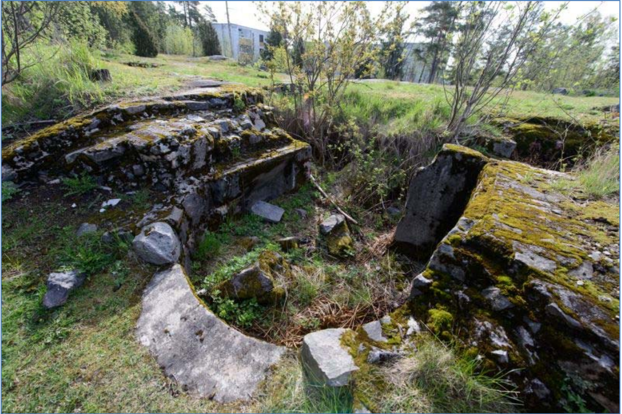
Konekivääriasema, jonka katto on räjäytetty. Asema on vanhempaa mallia, joka on varustettu kaarevalla etuseinällä. Rakennusmateriaaleina on käytetty muurattuja kiviä ja betonia. Kohde XX:6 Kannelmäki. Kuva: Museovirasto, Vesa Laulumaa 2014.
