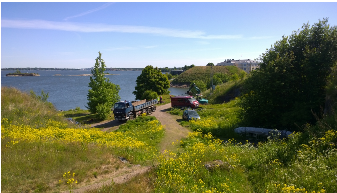
AKDG 5119:7. Työmaa käynnissä, lounaasta. Kuvaaja: Petro Pesonen.
