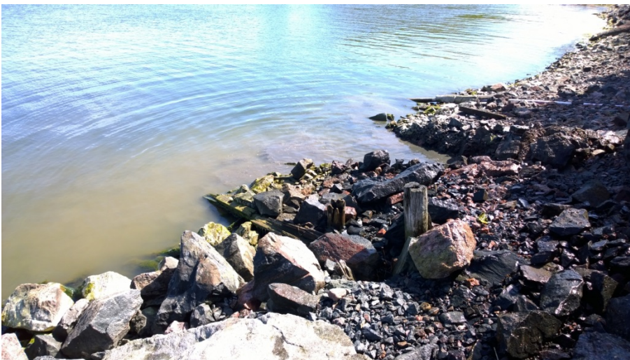
AKDG 5119:14. Puurakenteita vesirajassa, lounaasta. Kuvaaja: Petro Pesonen.
