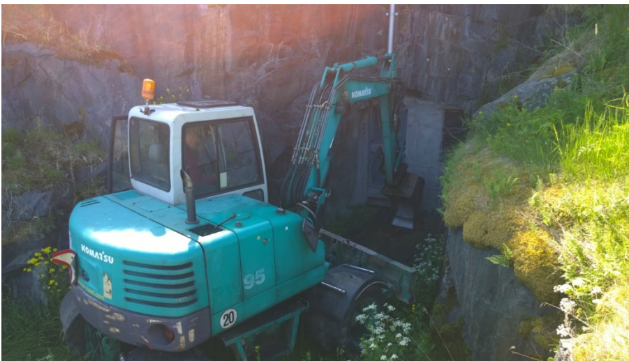
AKDG 5119:6. Kaapeliojaa kaivetaan luiskassa, luoteesta. Kuvaaja: Petro Pesonen.
