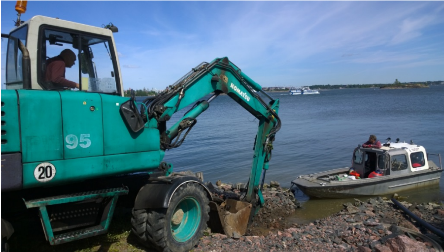
AKDG 5119:16. Kaivon paikan kaivua, kaakosta. Kuvaaja: Petro Pesonen.
