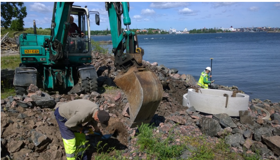
AKDG 5119:20. Mittausta ja kaivua, kaakosta. Kuvaaja: Petro Pesonen.
