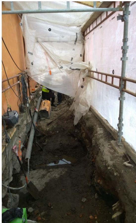
AKDG 5125:18. Yleiskuva luoteisseinän itäosan kaivannosta 20.2.2017, koillisesta. Kuvaaja: Petro Pesonen.
