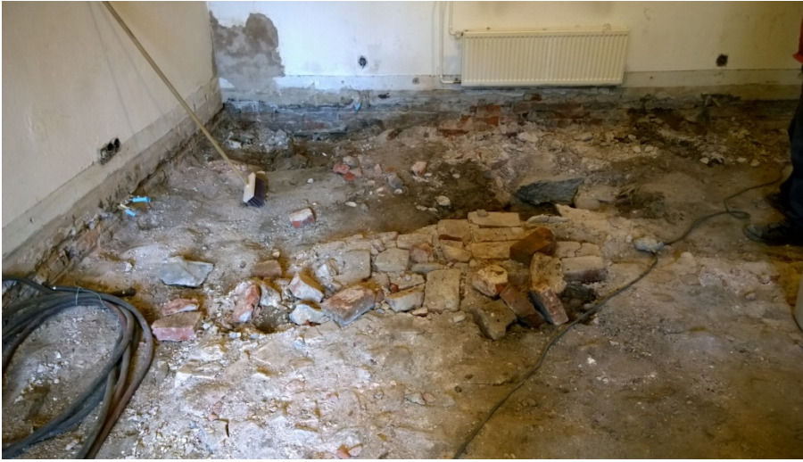
AKDG 5108:1. Tiililattian jätteitä piikattuna, etelästä. Kuvaaja: Petro Pesonen.
