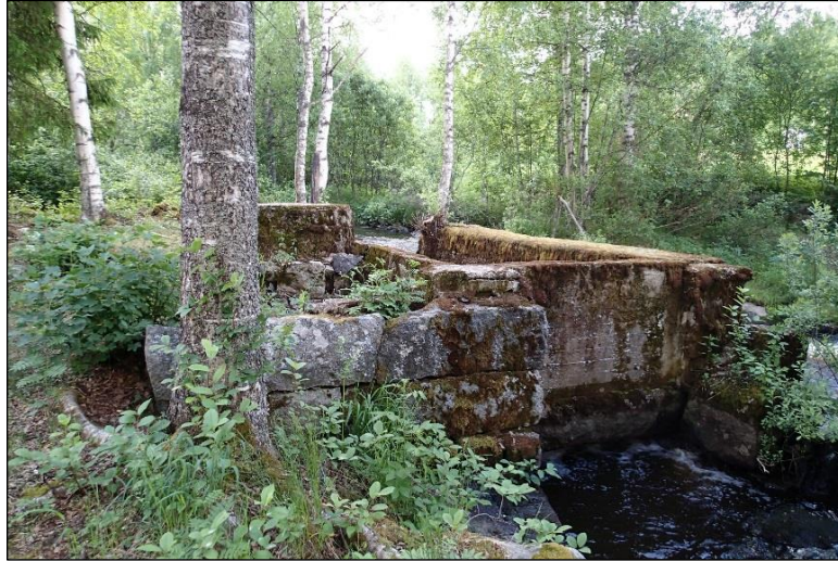
Osa koskessa olevista rakenteista on tehty betonista. Luoteeseen.
