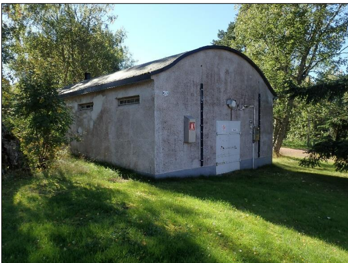
Edelleen käytössä oleva 1930-luvulla rakennettu varastorakennus sijaitsee Rankin koillisosassa. Etelään.
