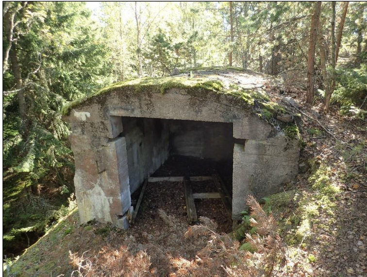
Kallion laen itäpuolella sijaitseva betoninen varastorakennus. Kaakkoon.
