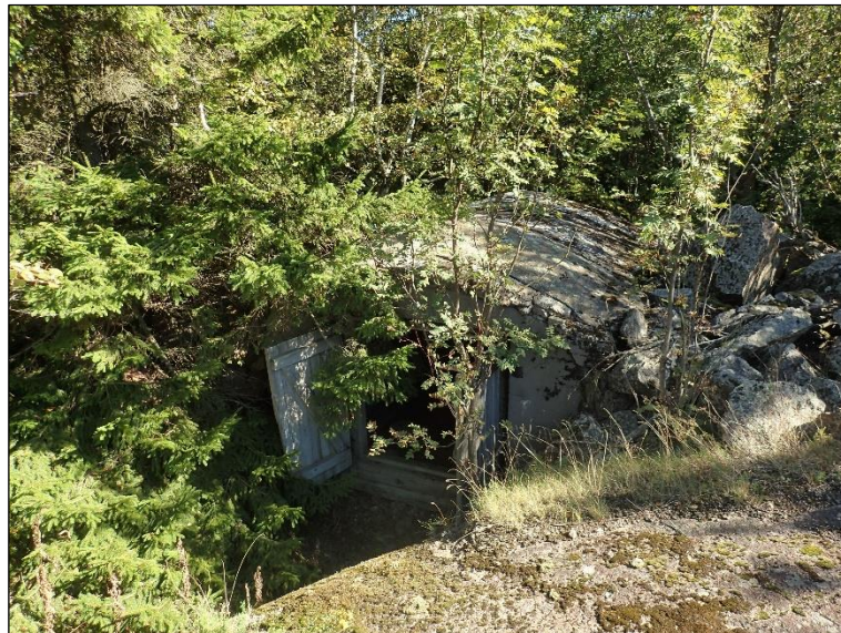
Kallion kupeessa sijaitseva betoninen varastorakennus. Itään.
