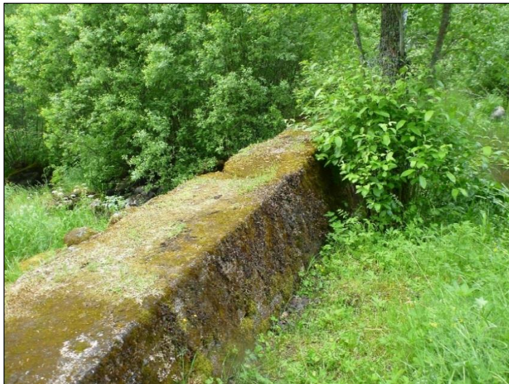
Myllypatoon uudempiä betonisia rakenteita. Kuvattu lounaaseen.
