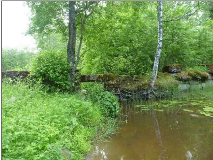
Myllypato etelään. Vanhemmat myllypatoon rakenteet näkyvät betonirakenteiden alla lähellä veden rajaa.
