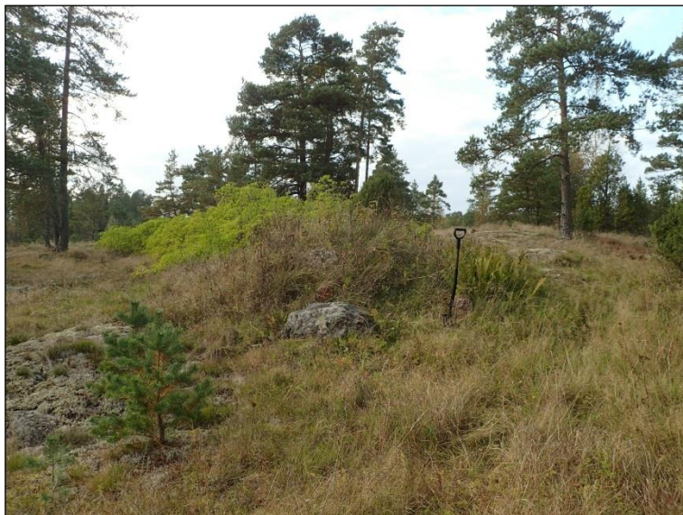
Heinittynyt kivi- ja maakasa rakennuksen perustan eteläpuolella. Pohjoiseen.
