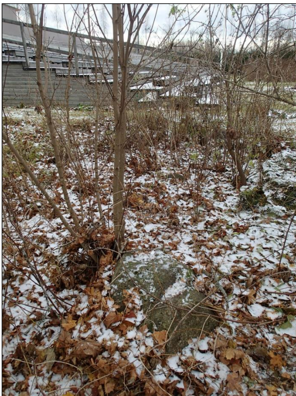
Katsomon eteläpuolella kohdassa N 6878657 E 345650 todettu rakennuksen peruskivi (etu- alalla). Taustalla katsomoa. Etelästä.
