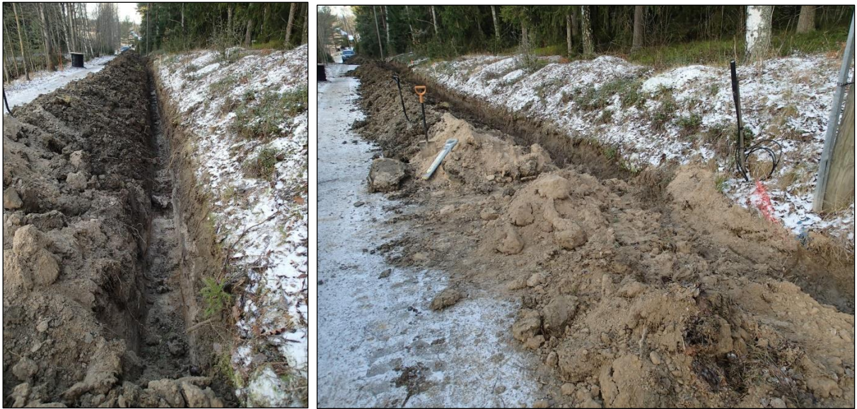
Vasen kuva: kaivannon itäpäätä (80 cm:n syvyyteen kaivettu osa). Itäkaakosta. Oikea kuva: yleiskuva linjasta valvonnan päättyessä. Kaakosta.
