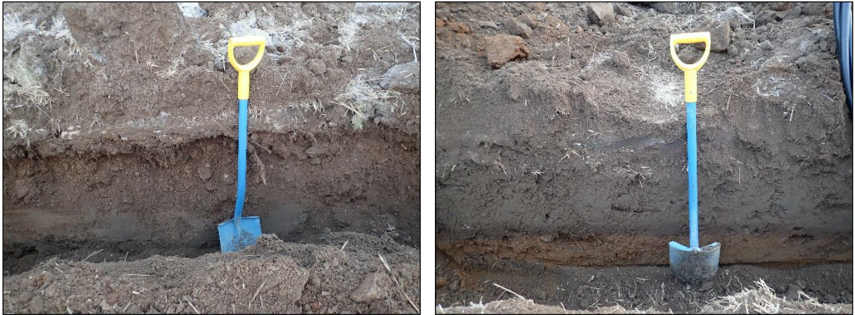
Vasen: kaapeliojan keskiosaa: peltokerroksen alla on sorakerros. Oikea: kaapeliojan pohjoisosaa, missä peltokerros on paksuun.
