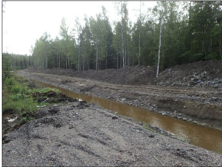
Uutta tielinjaa (?) ja sen ojaa suossa Kulomäentien eteläpuolella.
