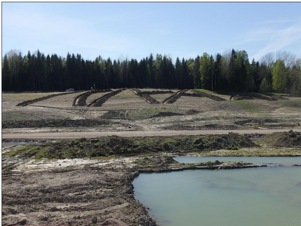
Koeoja kaivettuna muinaisjäännösalueelle. Kuvattu länteen.
