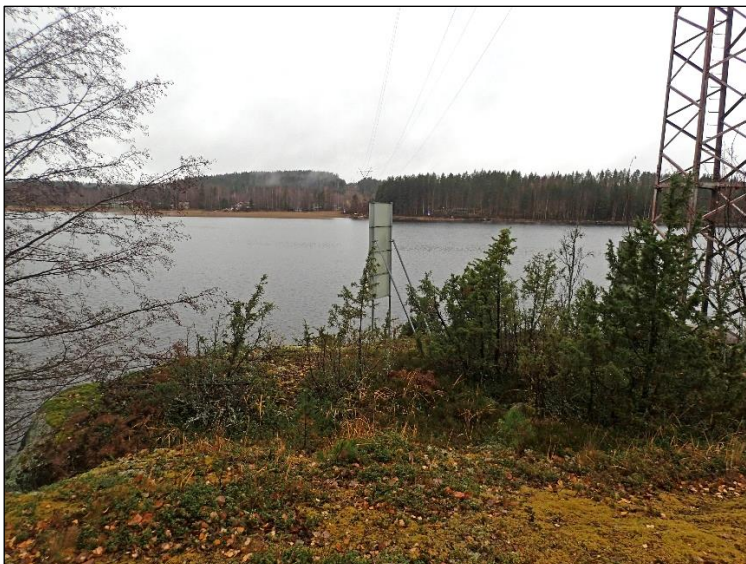
Voimajohtolinjan kulkua Jyväskylässä, Lapinsaaren länsilaidalla. Länteen.
