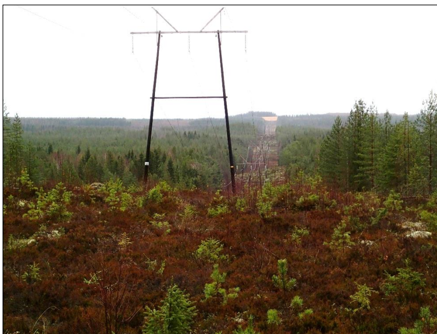
Voimajohtolinjaa Pieksämäen Ristimäen itäosasta kohti Perkainjokilaaksoa. Koilliseen.
