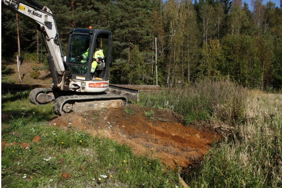
AKDG4907:5 Koeojaa 3 kaivetaan kaivinkoneella. S-N. Kuva Katja Vuoristo.
