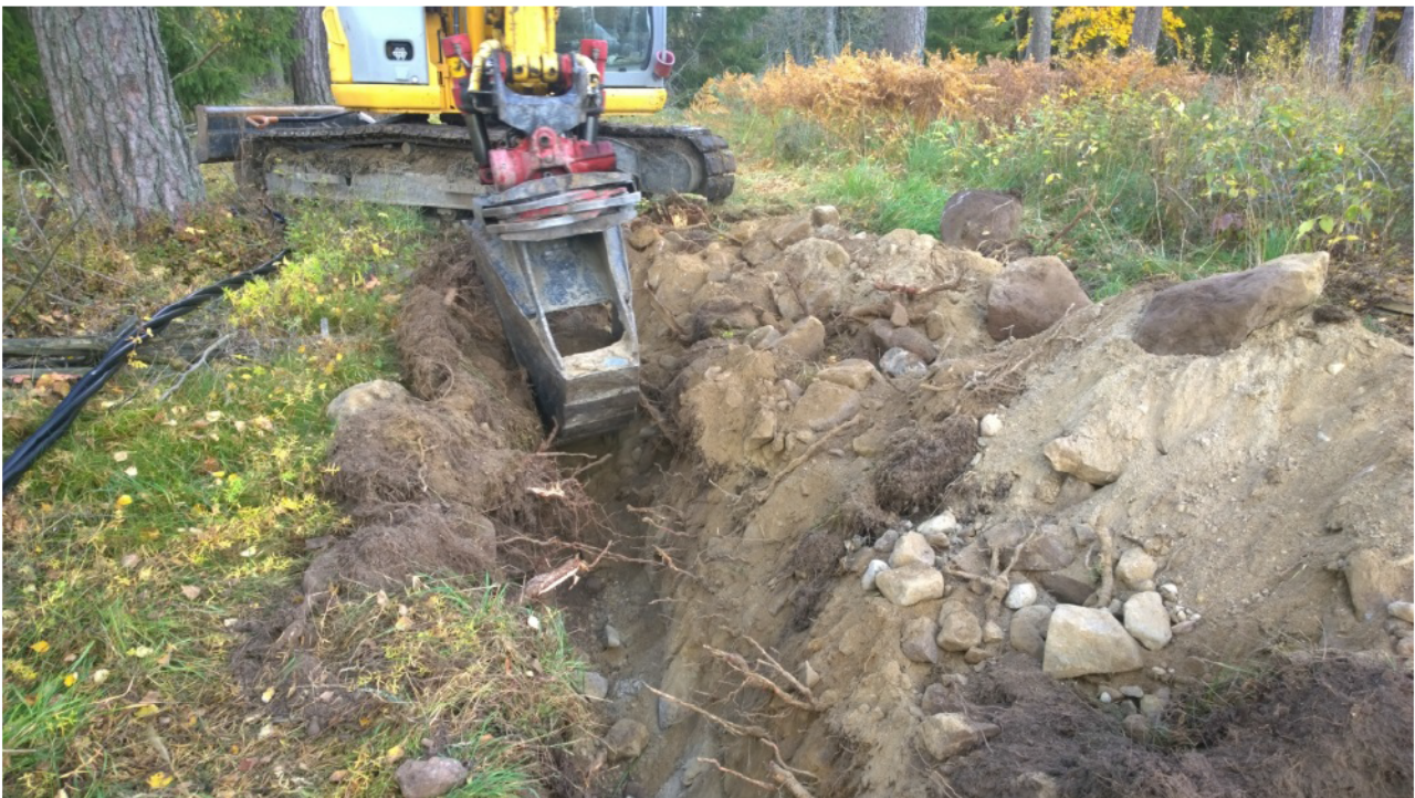
AKDG 4875:15. Louhisaari. Kaapeliojan kaivamista, hyvin kivistä metsämaata mäellä, kaakosta. Kuvaaja: Petro Pesonen.
