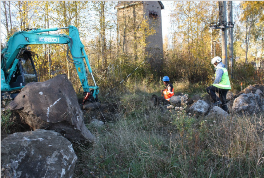
AKDG 4876:19 Saaren kartano. Työkuva. Suuria kivenjätkäleitä nostetaan kaivannosta pylväsmuuntajan ja tieuran välissä. Etelästä. Kuvaaja: Johanna Seppä.
