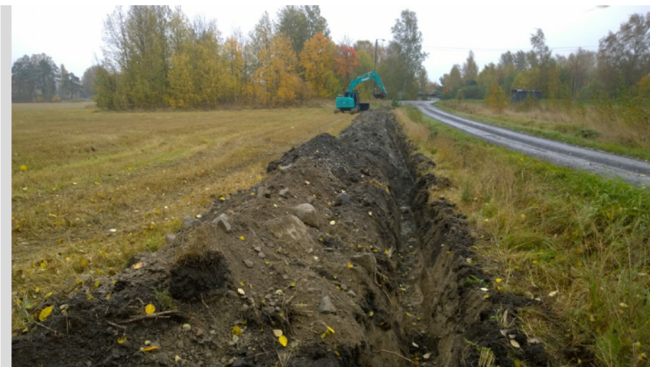
AKDG 4874:10. Askainen (Askais). Kaivanto valvotun alueen itäpäässä, lännestä. Kuvaaja: Petro Pesonen.
