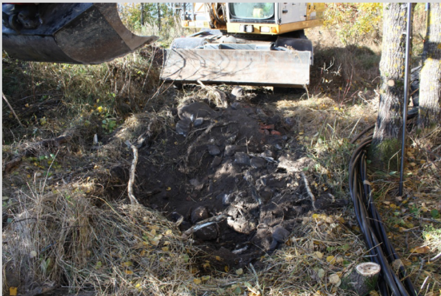
AKDG 4876:10. Saaren kartano. Puistomuuntajan kohtaa kaivetaan. Täyttömaassa on tiiliä ja pientä kiveä. Koillisesta. Kuvaaja: Johanna Seppä.
