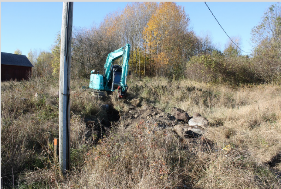
AKDG 4876:13. Saaren kartano. Työkuva. Kaapeliojaa aletaan kaivaa eteläpäästä tieuraa pitkin kohti Saarentietä. Maassa on suuria kiviä. Etelästä. Kuvaaja: Johanna Seppä.
