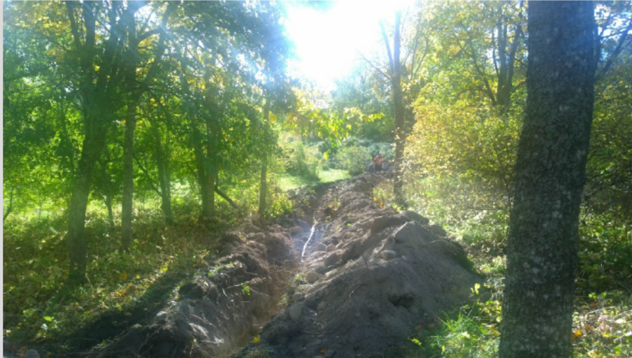
AKDG 4875:8. Louhisaari. Kaapelioja tammimetsästä puutarhaan, luoteesta. Kuvaaja: Petro Pesonen.
