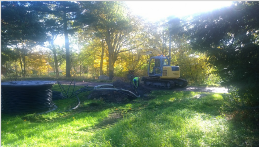
AKDG 4875:10. Louhisaari. Kaapelia asennetaan Louhisaaren läntisen pikkutien alitse, lännestä. Kuvaaja: Petro Pesonen.
