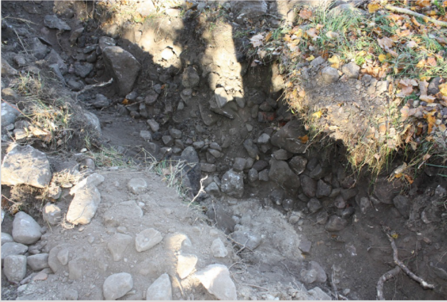
AKDG 4876:16. Saaren kartano. Täyttömaakivikkoa kaapelikaivannossa. Joukossa on asfaltin paloja. Lounaasta. Kuvaaja: Johanna Seppä.
