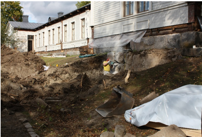
AKDG5203:3 Kellarin perustukseen avataan sisääntuloaukkoa. SW-NE. Kuva Katja Vuoristo.
