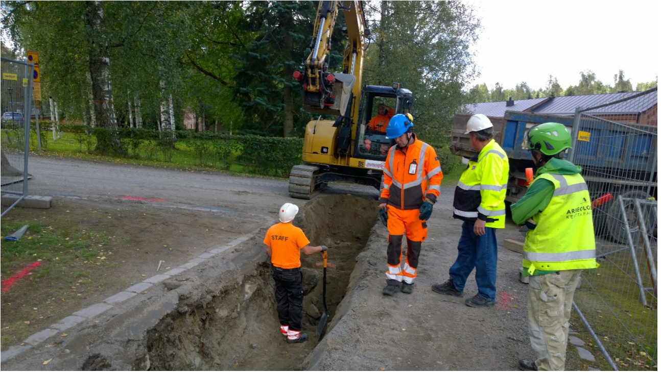
AKDG5203:10 Kaukolämpökaivantoa kaivetaan. Johanna Seppä valvoo kaivamista. N-S. Kuva Petro Pesonen.
