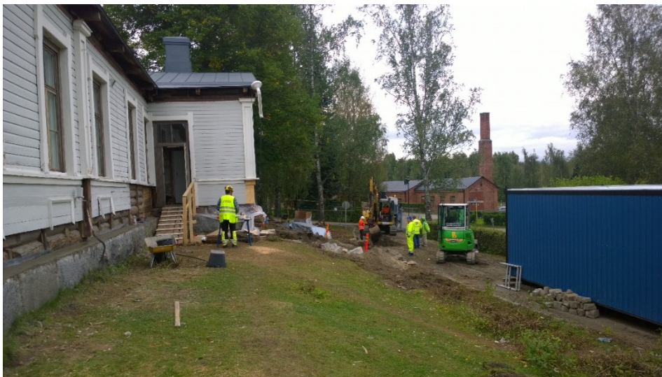
AKDG5203:8 Yleiskuva tutkimusalueesta. N-S. Kuva Petro Pesonen.
