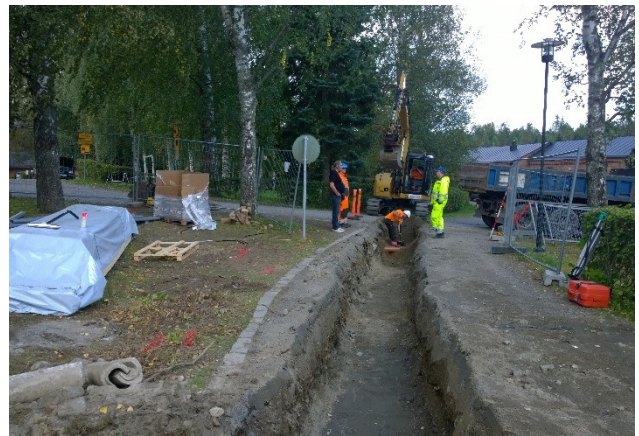
AKDG5203:11 Kaukolämpökaivannon eteläpäätä kaivetaan. Ojan poikki kulkee toinen oja. N-S. Kuva Petro Pesonen.
