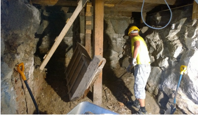
AKDG5203:6 Kellarin sisäpuoli, johon uusi sisääntuloaukko on avattu. N-S. Kuva Petro Pesonen.
