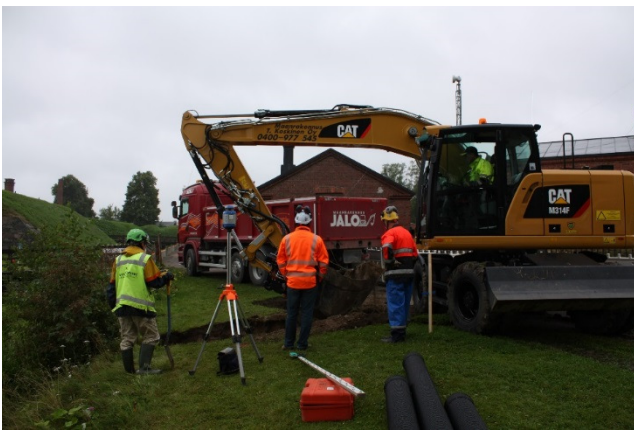
AKDG4721:68 Sadevesijärjestelmän kaivu aloitettiin rantapenkan vierestä. N-S. Kuva Katja Vuoristo.
