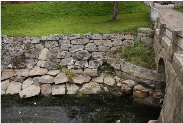
AKDG4721:64 ja AKDG4721:66 Eteläisen sillan länsipuolen eskarppimuurin korjausalue ennen kivien poistoa ja kivien poiston jälkeen. SE-NW ja S-N. Kuva Katja Vuoristo.
