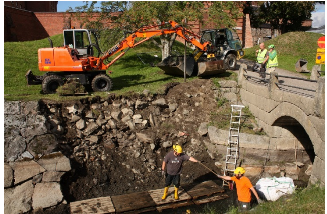
AKDG4721:64 ja AKDG4721:66 Eteläisen sillan länsipuolen eskarppimuurin korjausalue ennen kivien poistoa ja kivien poiston jälkeen. SE-NW ja S-N. Kuva Katja Vuoristo.
