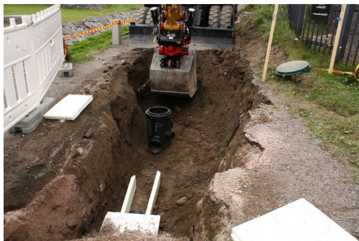
AKDG4721:70 Sadevesikaivannon asennus kaivantoon rannan sillan edustalla. N-S. Kuva Katja Vuoristo.
