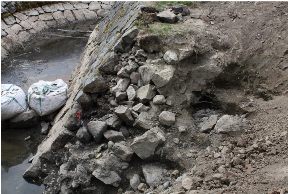
AKDG4721:53 Koekorjausalueen eskarppimuurin länsiprofiili. Muurin tauksen kivet on purettu jo osittain, mutta niiden kohdalla erottuu vielä kivistä saveen jääneet kuopat. NE-SW. Kuva Katja Vuoristo.
