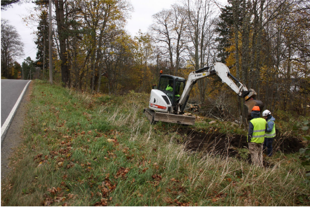
AKDG5174:1 Kaivausaluea avataan kaivinkoneella. Pohjoisesta. Kuva Katja Vuoristo.
