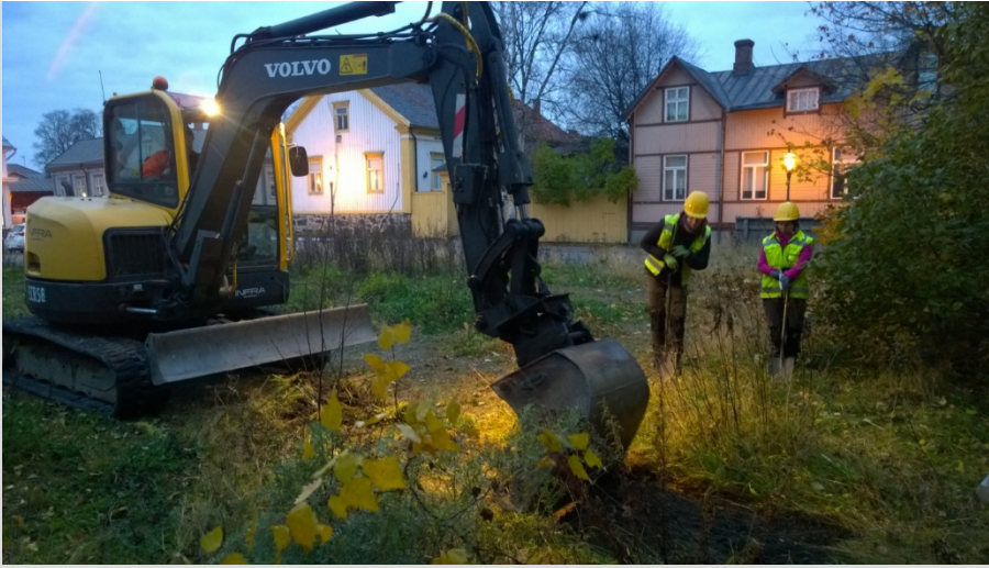
AKDG 5187:5. Työtä aloitellaan, etelästä. Kuvaaja: Petro Pesonen.
