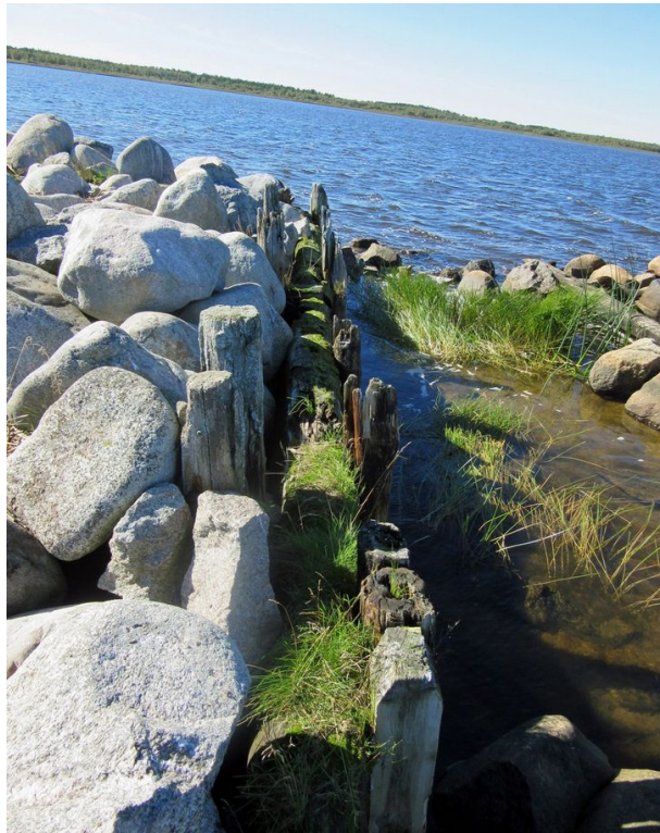
Laiturin perustuksen keskiosan rakenteita länteen.
