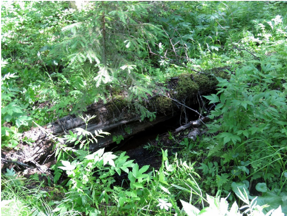
Rännin päälle oleva hirsirakenne kuvattu pohjoiskoilliseen.
